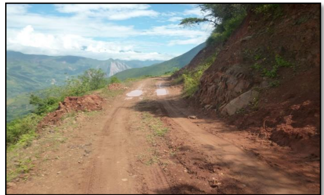
Falta de señalización en carretera Fuente: Propia
