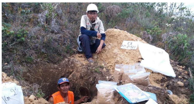
Foto N°15: Excavación de calicata Km 2+500
