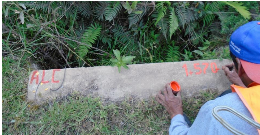
Foto N° 11: Identificación de alcantarilla en el kilometraje
