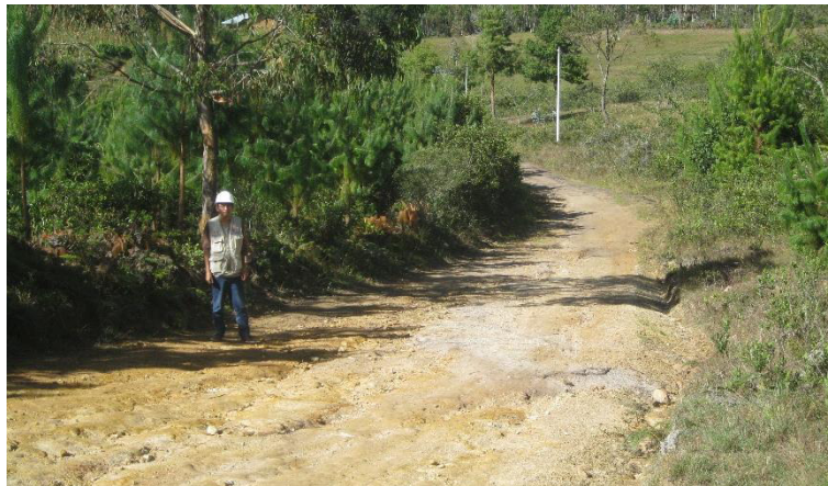
Foto N°5: Desgaste de la carretera.
