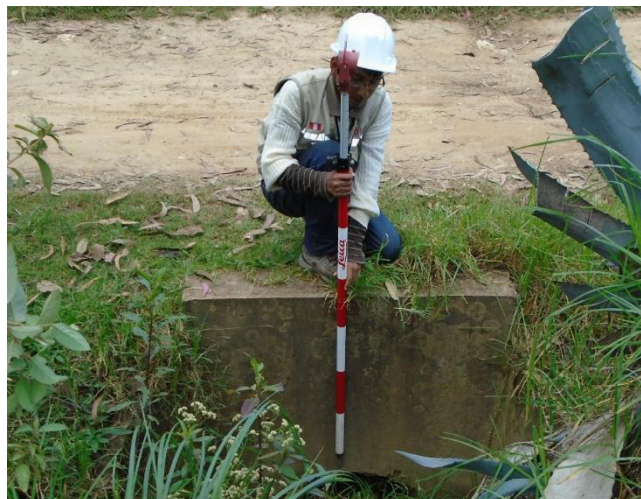
Foto N°9: Midiendo dimensiones de alcantarilla
