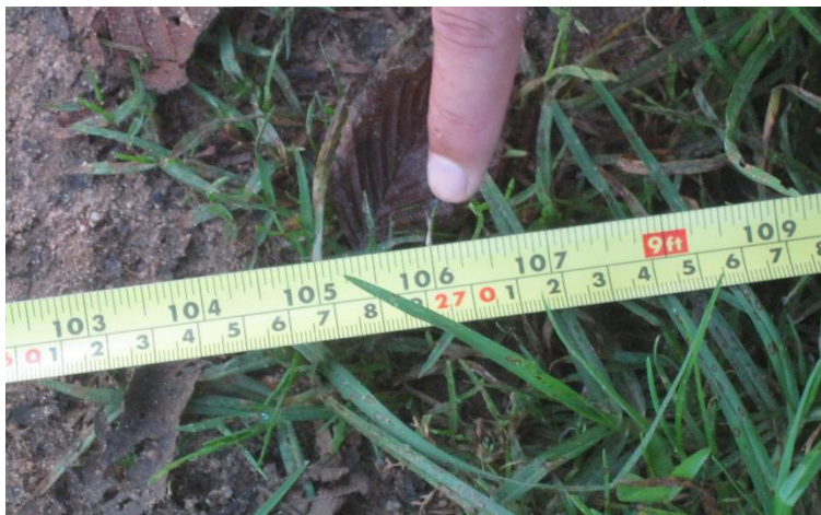
Foto N°6: Medición la carretera en donde hay disminución del ancho de vía.
