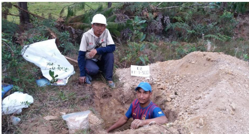
Imagen N° : Excavación de calicata Km 1+500
