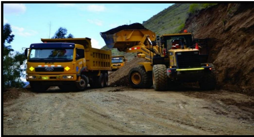
Figura 1.3: Asfaltado de Carretera Luricocha-Santillana
