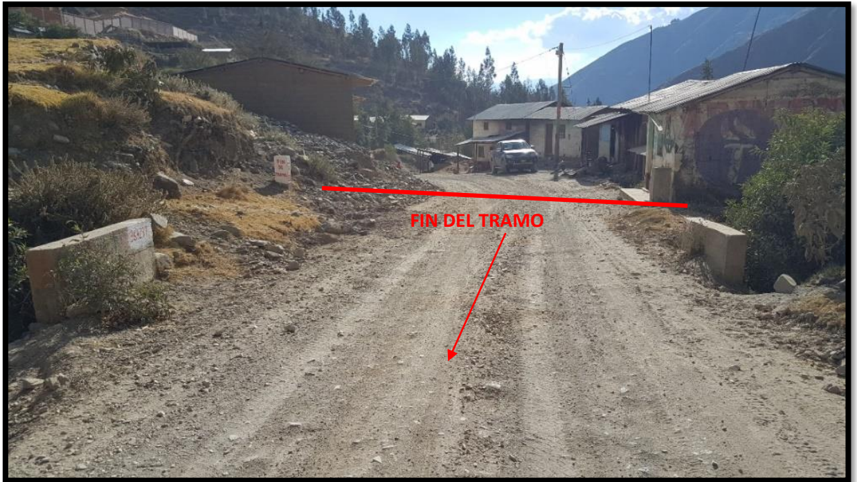
Imagen 3: Tramo final de carretera
