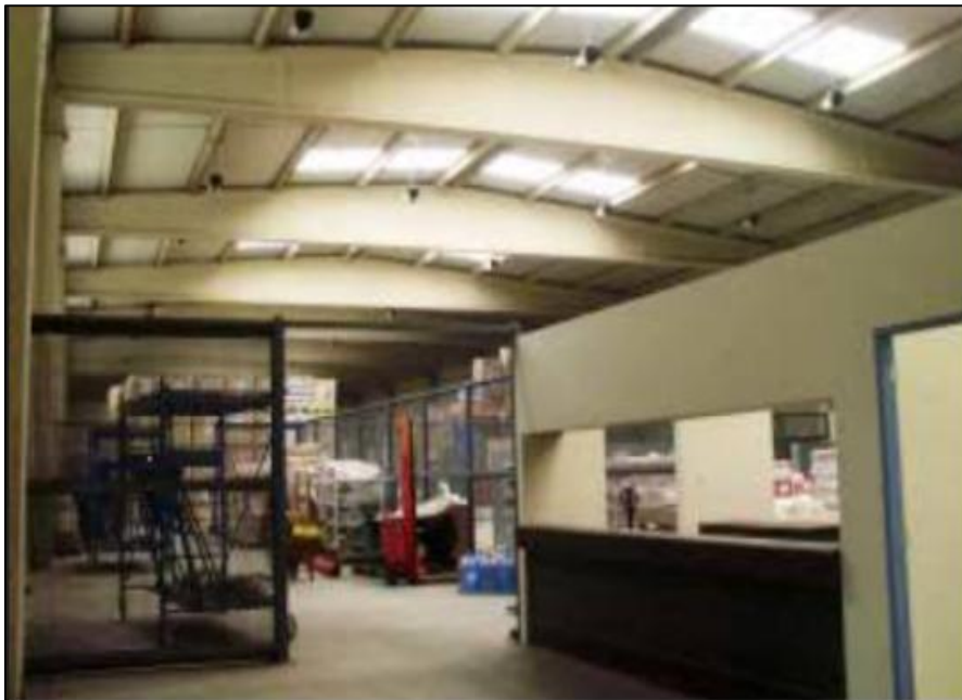
Figura N°47: Almacén mejorado en Continental S.A.C
