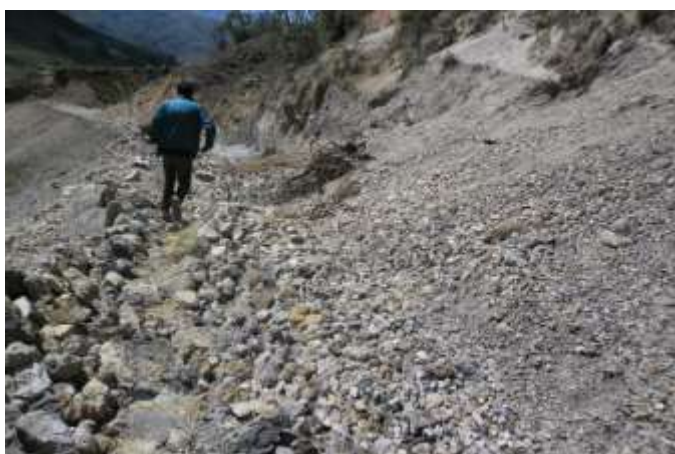
Ilustración 10. Derrumbes en trocha carrozable.
