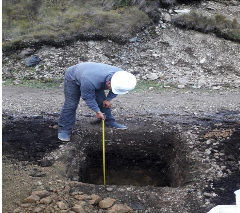
Fig. 11: Realizando medidas hasta llegar a la profundidad correcta.
