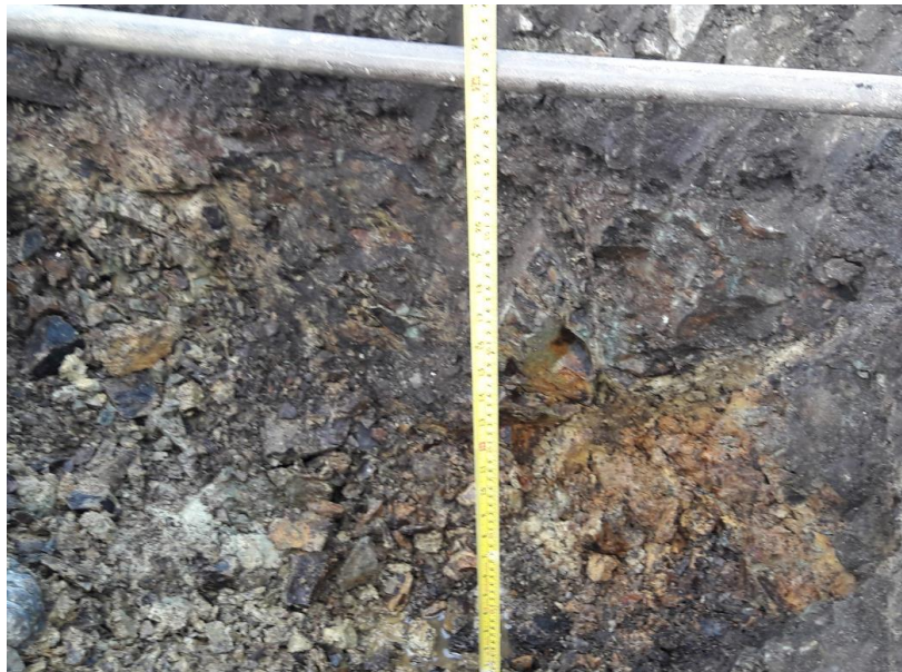
Fig. 12: Retiramos la muestra para CBR a 60cm.
