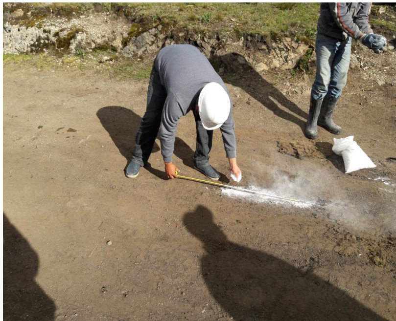
Fig. 8: Realizando el trazo de la calicata de acuerdo a las medidas reglamentarias.
