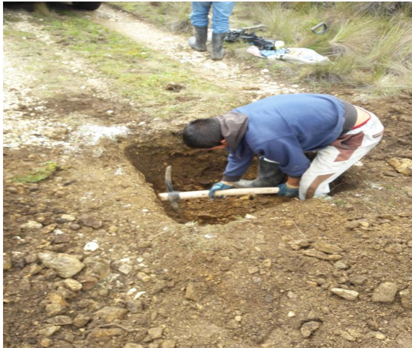
Fig. 9: Realizando la excavación de la calicata.
