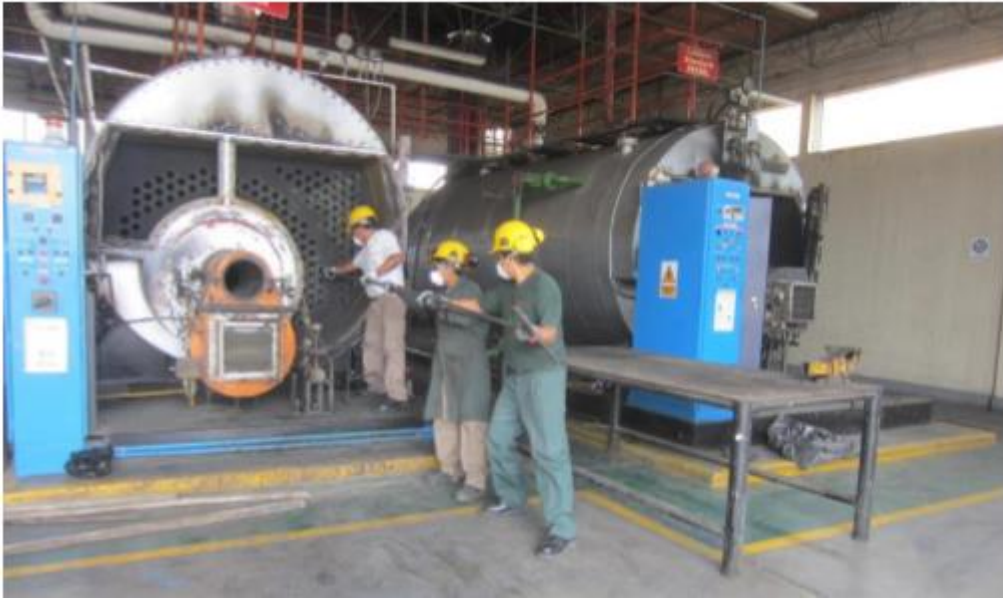
Foto 03: mantenimiento programado – limpieza de tubos de fuego
