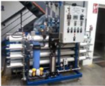
Imagen N°1 Vista referencial de un equipo de Osmosis Inversa de 2,5 m3/h
