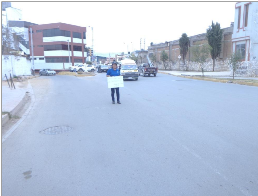
Figura N° 12 Av. Centenario – Huancayo- Junín 2017 –Deficiente Señalización Horizontal
