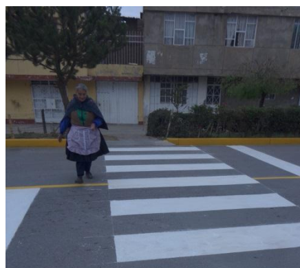
Figura N° 22 Av. Circuito Los Héroes – Huancayo- Junín 2017 – Pintura de tráfico a libre tránsito y peatonal.
