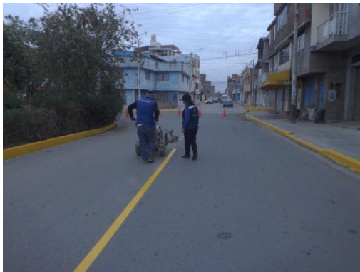
Figura N°21 Av. Circuito Los Héroes – Huancayo- Junín 2017 –Equipo airless para aplicación de pintura
