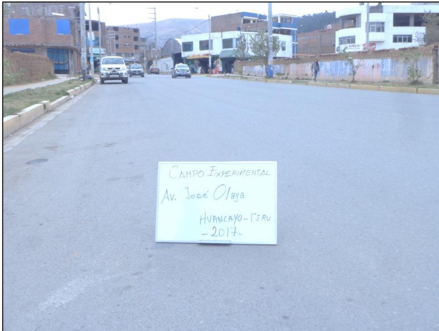
Figura N°8 Av. José Olaya – Huancayo- Junín 2017 –Deficiente Señalización Horizontal
