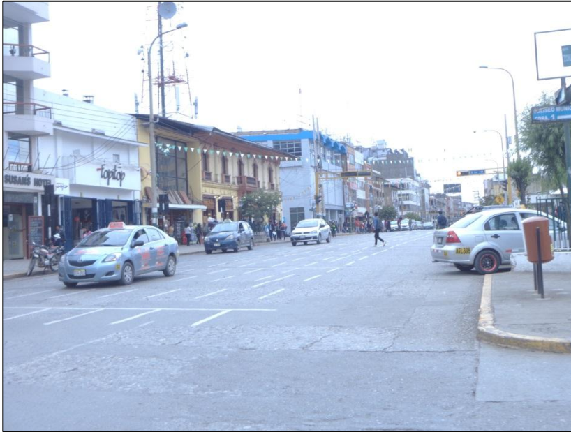
Figura N°5 Av. Real – Huancayo- Junín 2017 –Deficiente Señalización Horizontal.
