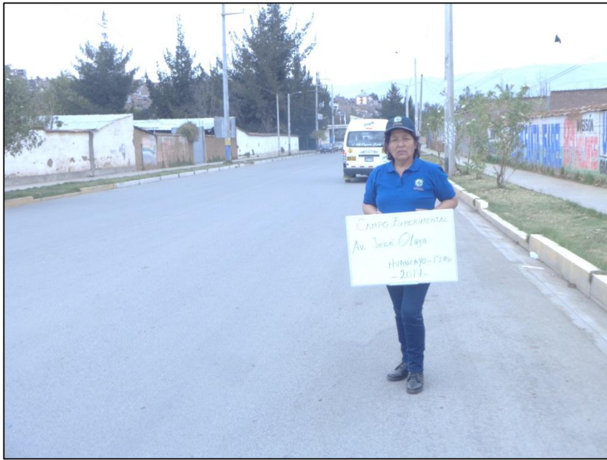
Figura N°7 Av. José Olaya – Huancayo- Junín 2017 –Deficiente Señalización Horizontal
