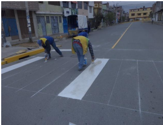
Figura N°18 Av. Circuito Los Héroes – Huancayo- Junín 2017 – aplicación de las pinturas en forma manual.
