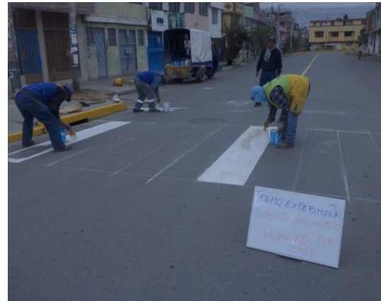
Figura N°18 Av. Circuito Los Héroes – Huancayo- Junín 2017 – aplicación de las pinturas en forma manual.
