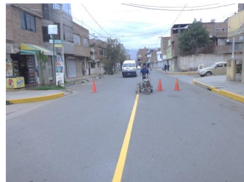
Figura N°21 Av. Circuito Los Héroes – Huancayo- Junín 2017 –Equipo airless para aplicación de pintura
