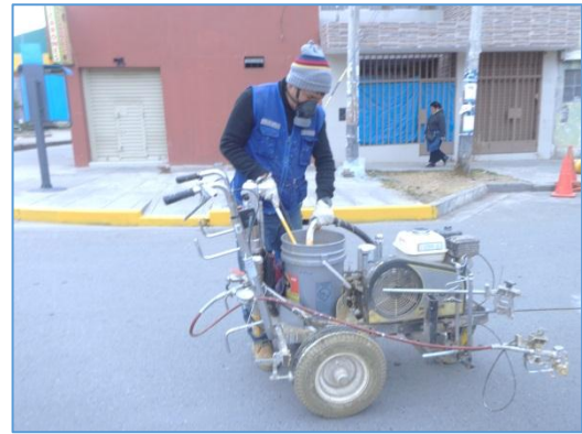
Figura N° 20 Av. Circuito Los Héroes – Huancayo- Junín 2017 – La pintura se debe homogenizar para evitar la obstrucción de salida de la pintura por la boquilla del equipo de aplicación.
