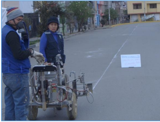
Figura N° 20 Av. Circuito Los Héroes – Huancayo- Junín 2017 – La pintura se debe homogenizar para evitar la obstrucción de salida de la pintura por la boquilla del equipo de aplicación.
