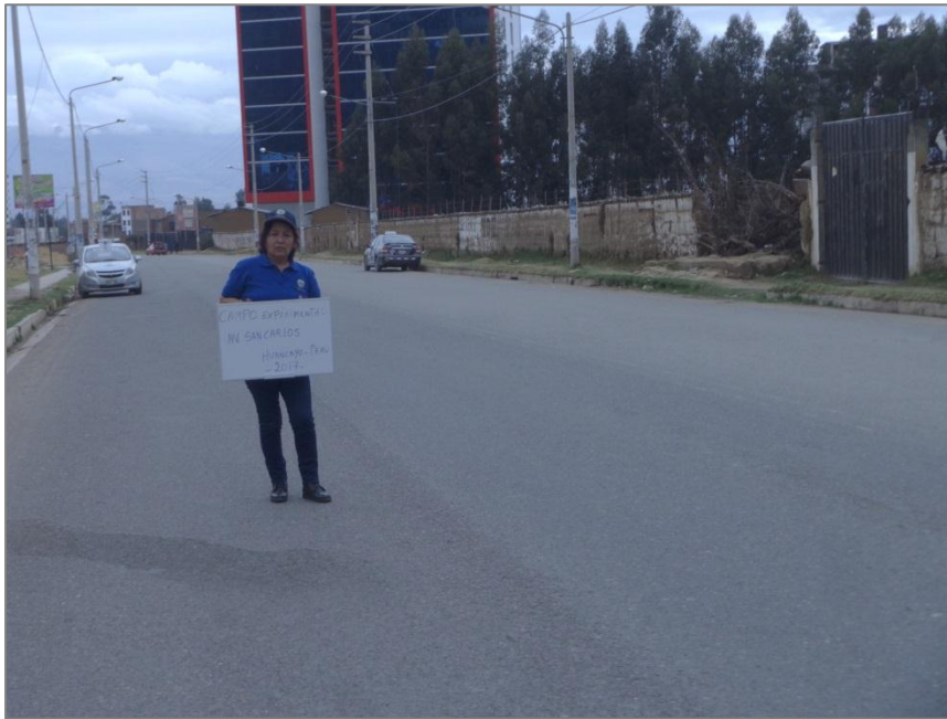
Figura N°9 Av. San Carlos – Huancayo- Junín 2017 –Deficiente Señalización Horizontal
