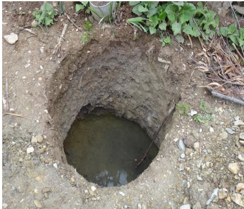
Figura III-5: Excavación de calicata de la primera caracterización. Fuente: Propio.
