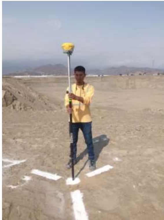
Figura III - 12 Lectura de las coordenadas con el modo RTK del GPS.
