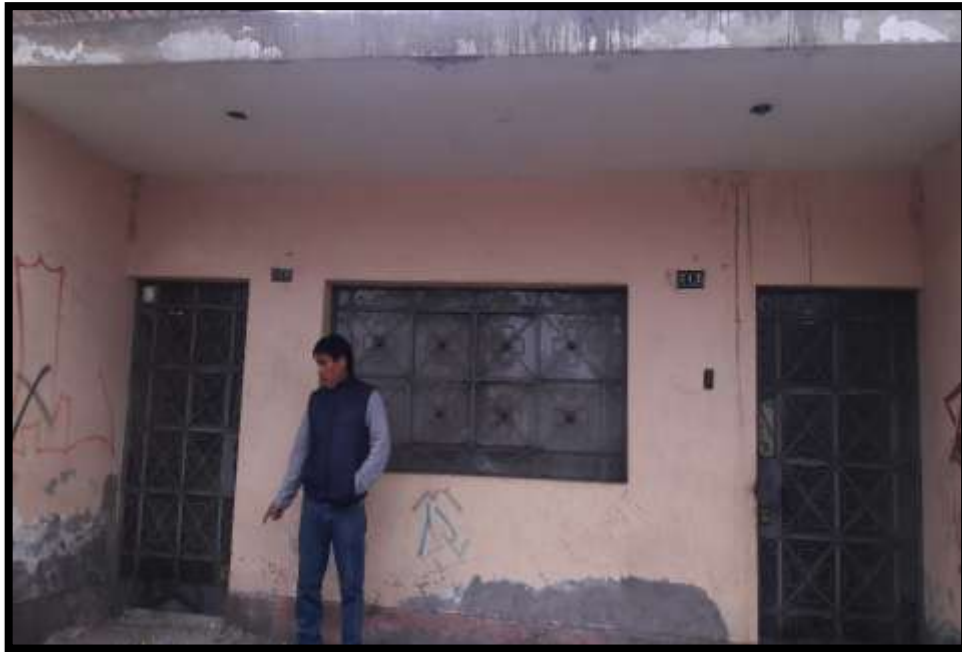
Vista N°4: Se puede apreciar el daño de desprendimiento de pintura, en el acabado en la pared exterior de la vivienda.
