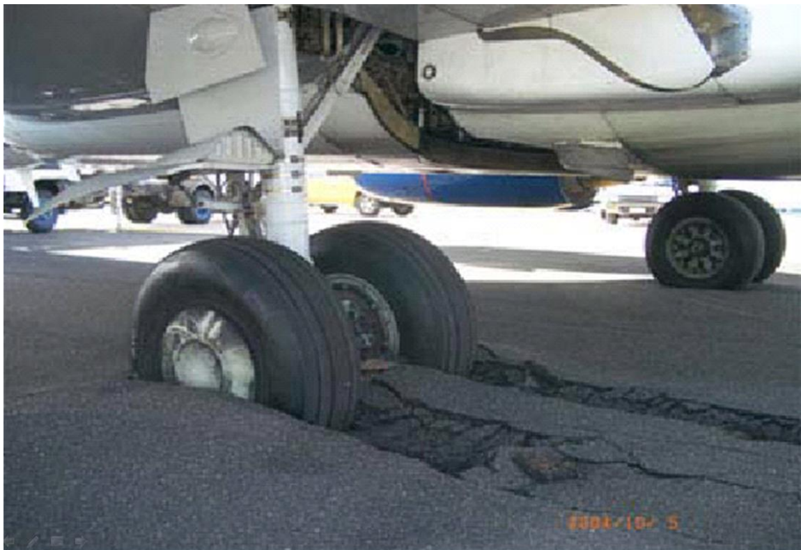
Figura 26. Daño generado al pavimento por el uso del pavimento de una aeronave con un ACN > PCN.
