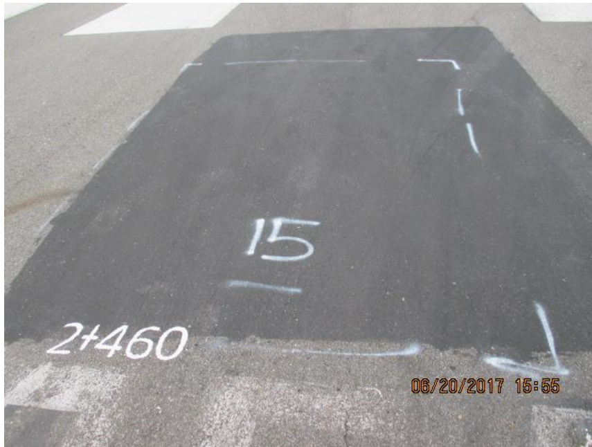
Figura 93. Evaluación de PCI Fuente: Propia
