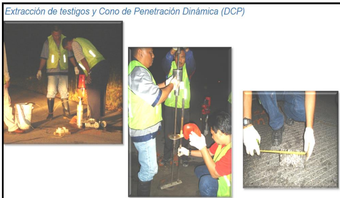
Figura 24. Extracción de testigos – ensayos estructurales (destructivos) Fuente: Curso de Capacitación de mantenimiento de pavimentos - AdP
