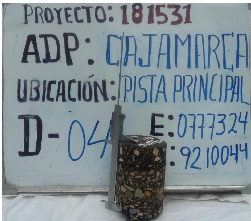
Figura 114. D-04.-Proceso de extracción de núcleo diamantino en la pista de aterrizaje Fuente: EFE – 2015 - AdP
