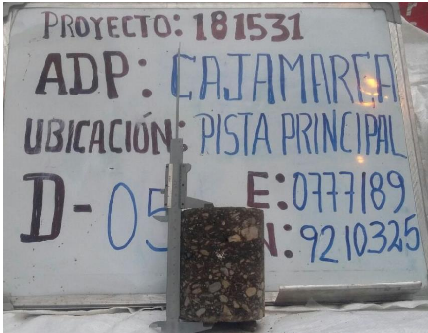
Figura 115. D-05.-Proceso de extracción de núcleo diamantino en la pista de aterrizaje Fuente: EFE – 2015 - AdP
