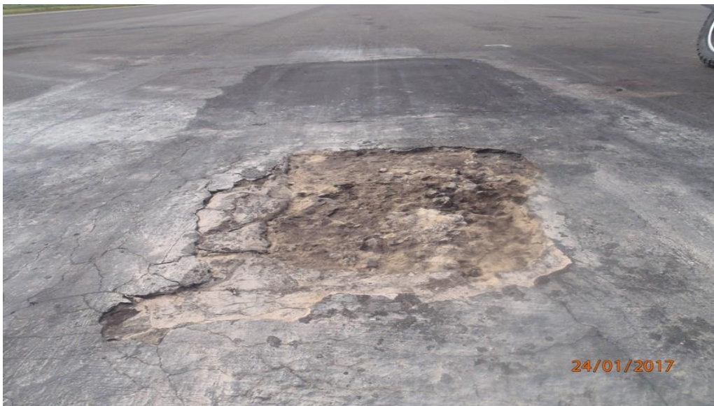
Figura 4. Fallas piel de cocodrilo que por su severidad generan cierre de la RWY Fuente: Propia
