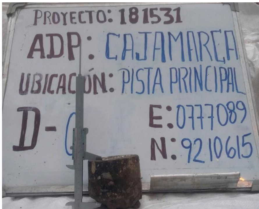
Figura 116. D-06.-Proceso de extracción de núcleo diamantino en la pista de aterrizaje Fuente: EFE – 2015 - AdP
