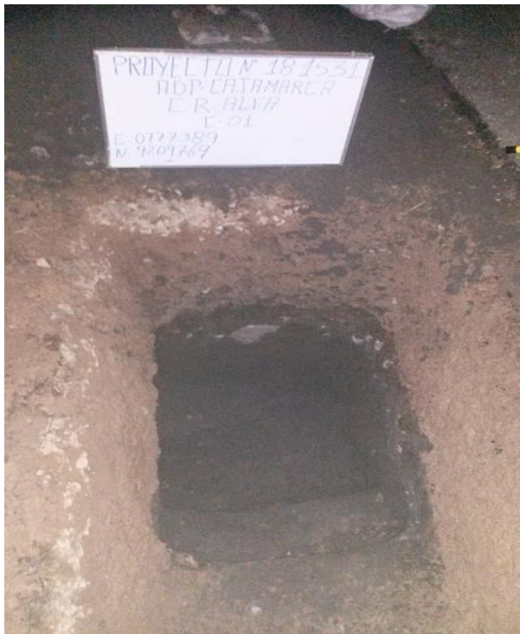
Figura 122. Excavación de calicata Ejecución de la prospección a tajo abierto (calicata), al borde del margen de la calle de rodaje alfa, para calcular la capacidad portante (CBR) del terreno de fundación.
