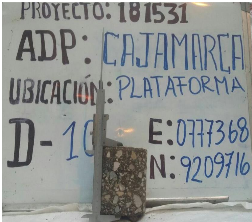
Figura 120. D-10.-Proceso de extracción de núcleo diamantino en la pista de aterrizaje Fuente: EFE – 2015 - AdP
