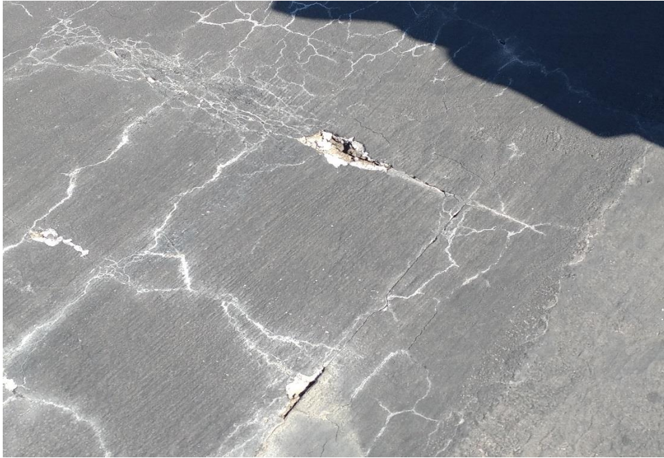
Figura 3. Fallas estructural que no se identifican e intervienen a tiempo. Fuente: Propia
