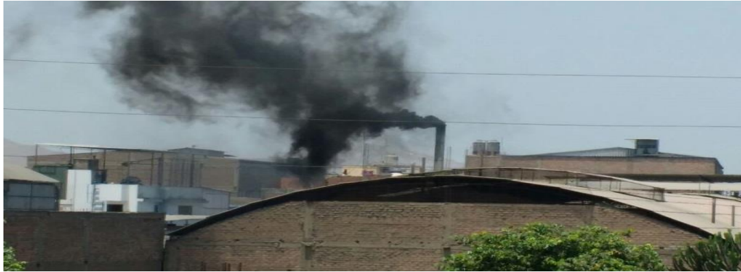
Fábrica metalmecánica y soldaduras.
