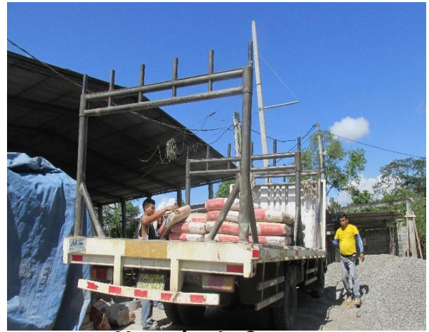
Almacén de Cemento
