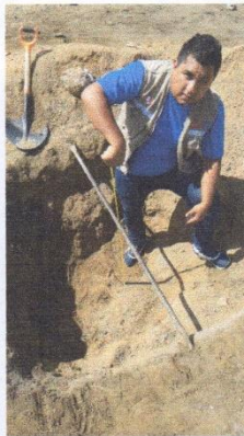
En la imagen se aprecia la medición de la calicata para ir viendo la profundidad de excavación..
