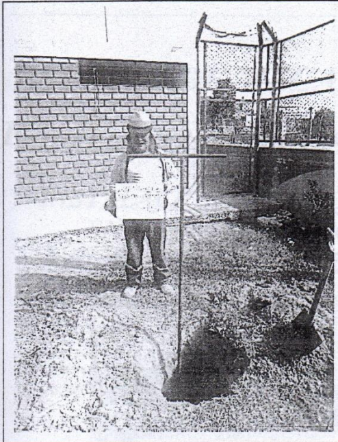
Foto N°03: Vista de la C-02, en la superficie (0.30m) presencia de arena limosa y vegetación. De 0.30m a 3.00m de profundidad presencia de arena mal graduada (SP), medianamente compacto a compacto, ligeramente seco de color beige claro.
