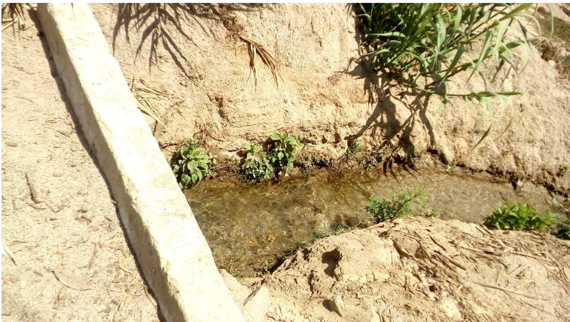
Fotografía N° 04: Canal de terreno natural que conduce el agua hasta las parcelas de cultivo.
