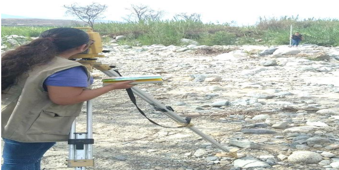
Fotografía N° 20: Realizando el levantamiento topográfico en el punto de captación del canal del Caserío Quillhuay.
