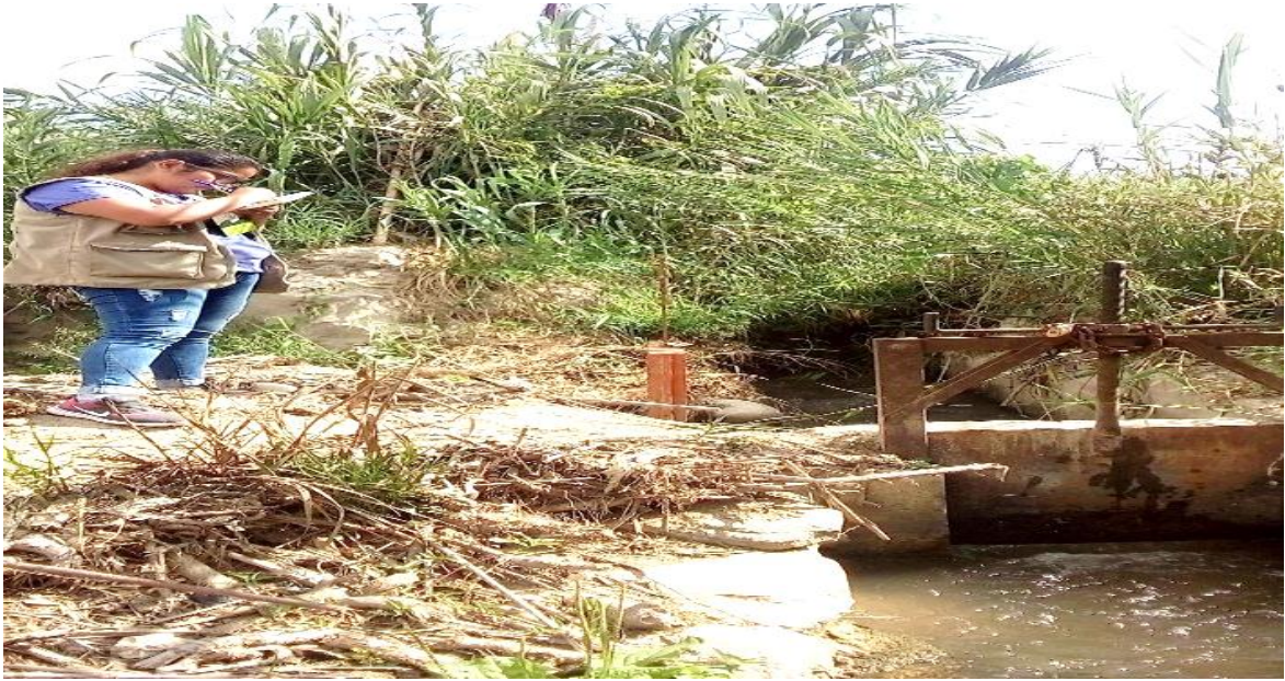
Fotografía N° 13: Identificando las características del abastecimiento existente del Caserío Quillhuay.
