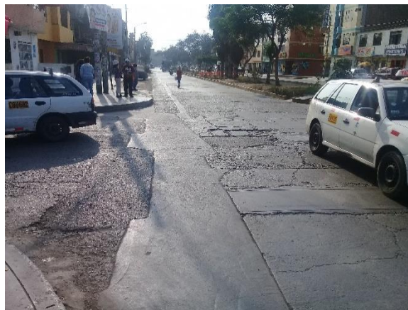
Figura 15. Av. Guillermo de la fuente Fuente: Elaboración propia
