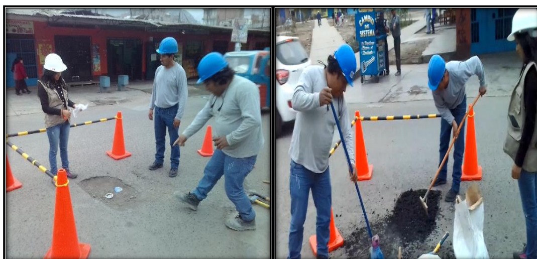
Figura 42. Proceso de intervención de bacheos y parches. Elaboración propia, 2018.
