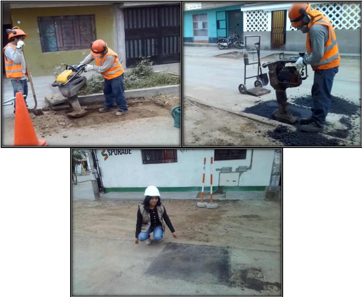
Figura 44. Recapeo asfáltico o sobrecarpeta. Elaboración propia, 2018.
