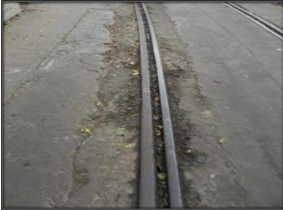
Figura 23. Cruce de Vía Férrea. Tomado de “Cálculo del índice de condición del pavimento (PCI)”, por Robles, R., 2015, p. 82, por Universidad Ricardo Palma.
