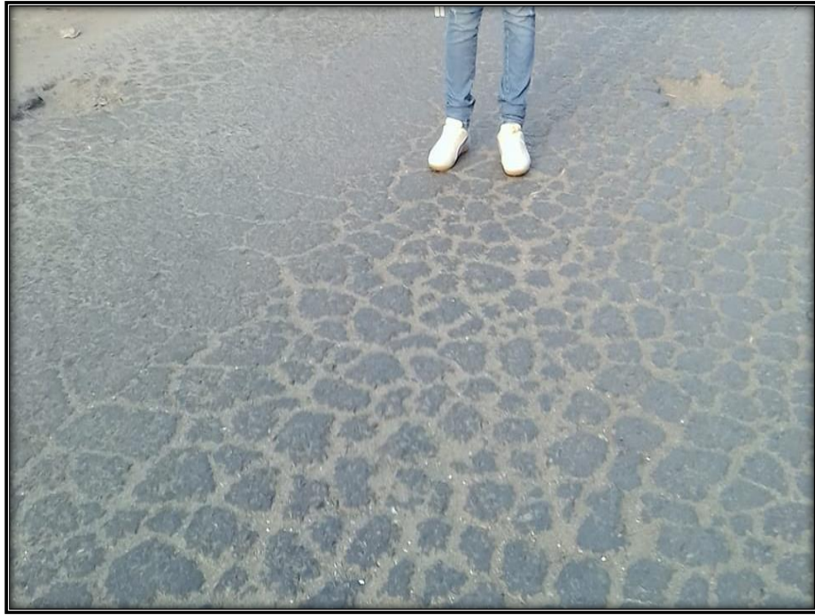
Figura 50. Piel de cocodrilo en la Av. Ferrocarril
