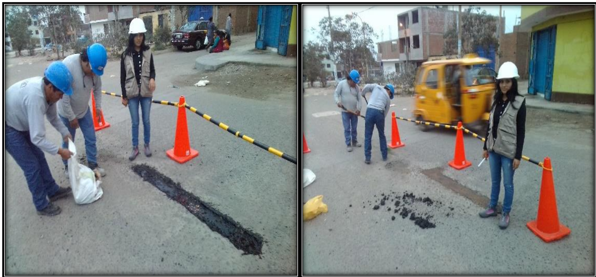
Figura 43. Sellado de fisuras y grietas. Elaboración propia, 2018.
