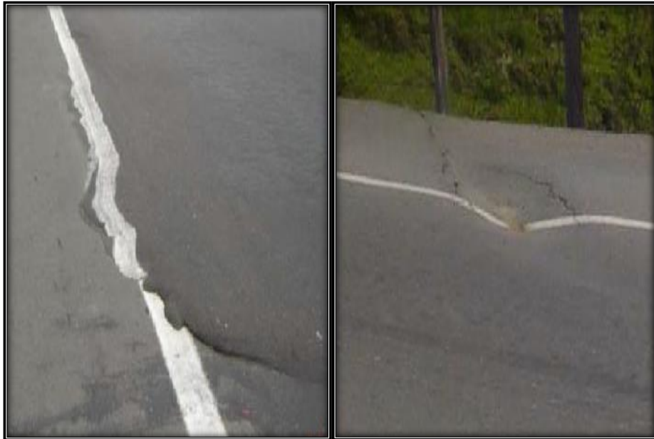
Figura 11. Abultamientos y hundimientos. Adaptado de “Cálculo del índice de condición del pavimento flexible”, Por Rodríguez, D., 2009, p. 15, por Universidad de Piura.
