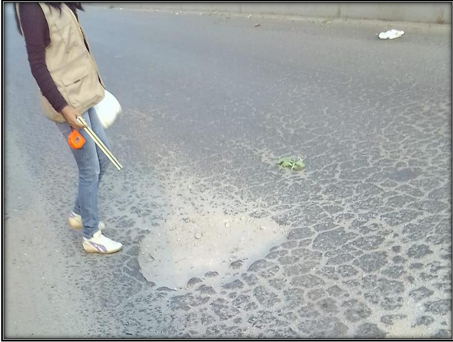
Figura 52. Baches en la Av. Ferrocarril
