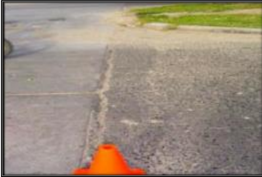
Figura 17. Desplazamiento. Adaptado de “Cálculo del índice de condición del pavimento flexible”, Por Rodríguez, D., 2009, p. 23, por Universidad de Piura.
