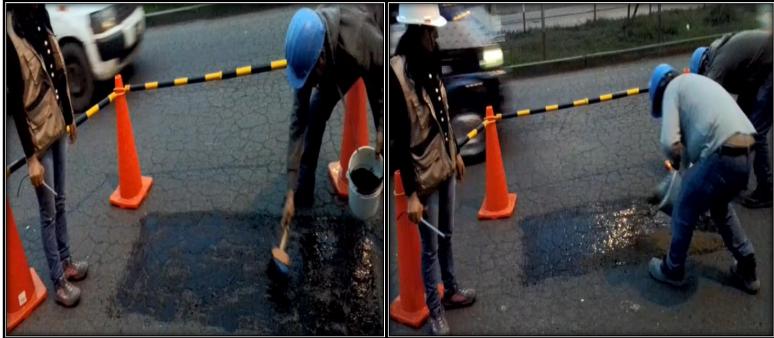
Figura 45. Riego de liga – arena en piel de cocodrilo. Elaboración propia, 2018.
