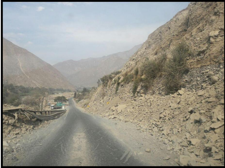
**Fotografía N°15. Daños en la carretera Lima – Canta por efecto de deslizamientos.**
