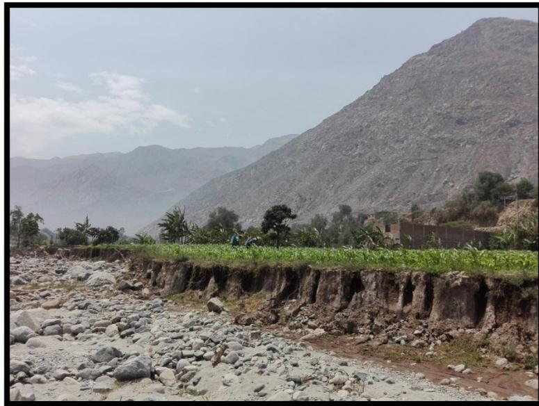
**Fotografía N°8. Se observa que el flujo de agua ha ido socavando el área agrícola que existe en la localidad de Yangas.**
