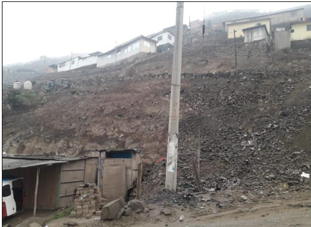
Figura 35: Riesgo de deslizamiento de material rocoso en viviendas inferiores al talud 2
