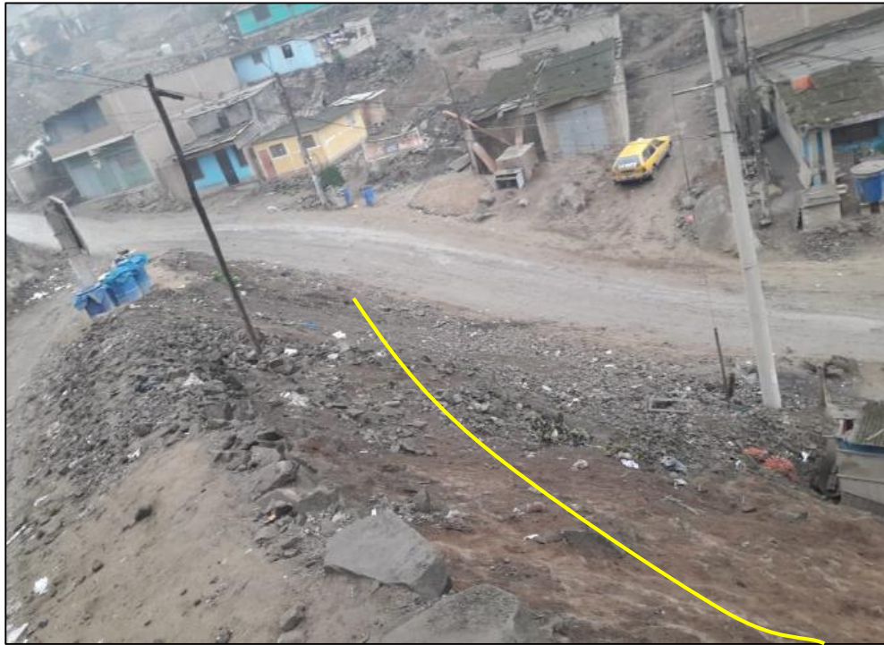
Figura 32: Vista lateral del Talud 3(Cruce Chacón Inferior)
