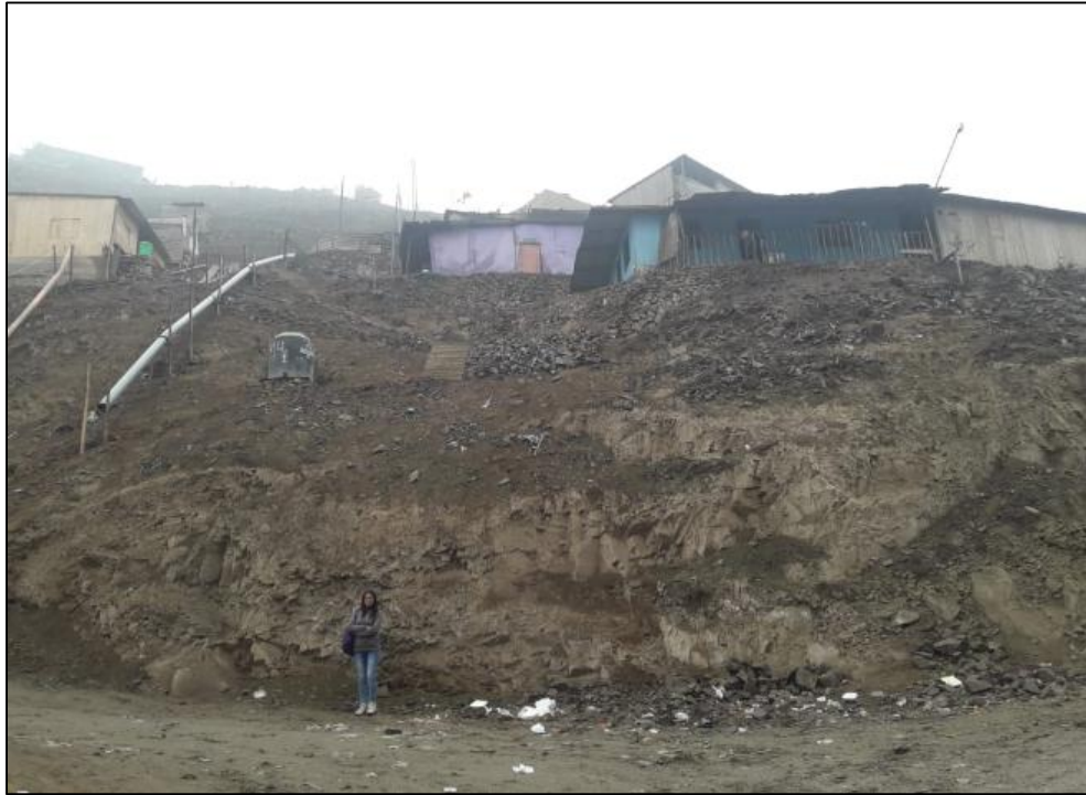
Figura 30: Vista Frontal del Talud donde se proyectará el muro de contención
