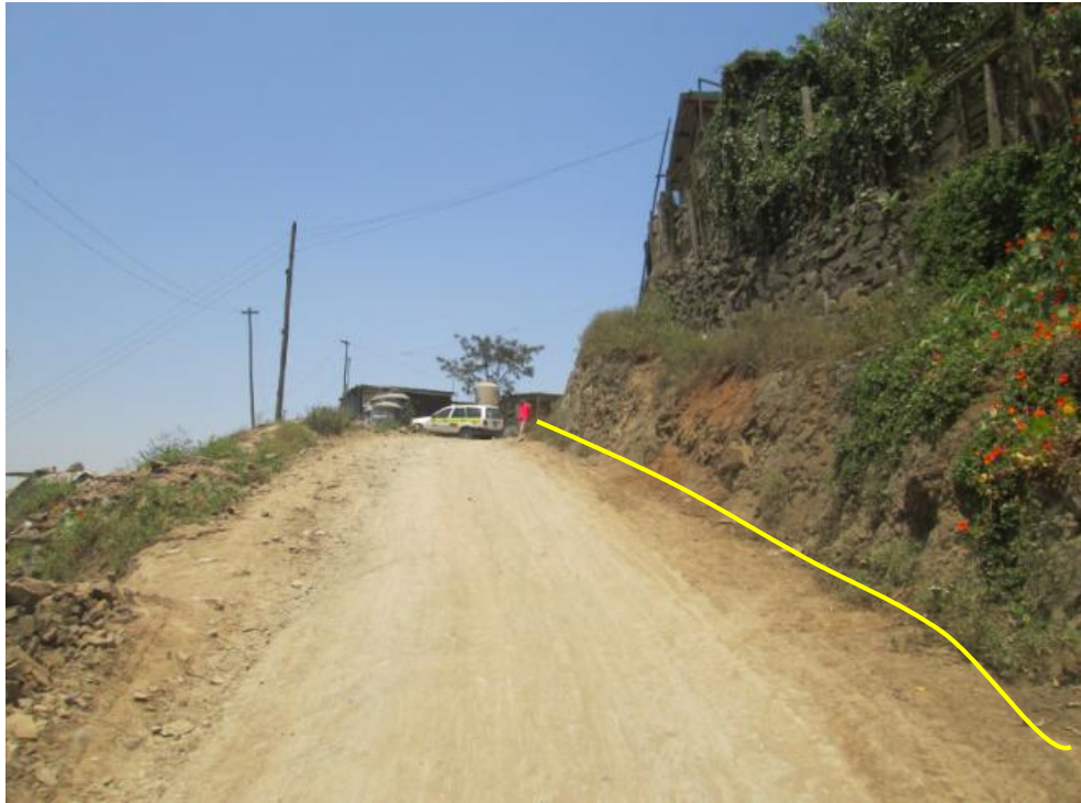
Figura 26: Viviendas ubicadas en la punta del talud
