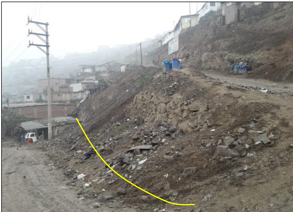
Figura 33: Ubicación del muro 3 (Cruce Chacón inferior)
