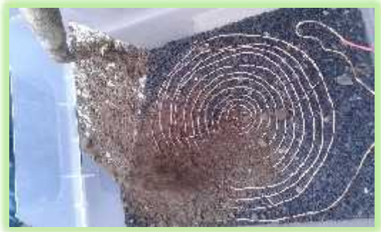
15. Sobre el aspirar tejido con hilos de cobre se le coloca 20 cm de tierra preparada
