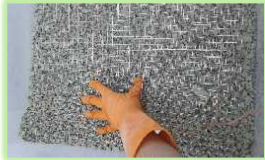
7. Colocación de 10 cm de grava (3-6mm) y malla tejida con cable de cobre
