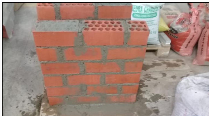
Figura 21: Murete Elaborado con Mortero Convencional
