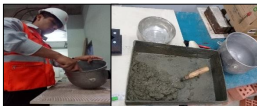
Figura 39: Mezclado del Mortero Embolsado con la proporción de Agua Requerida
