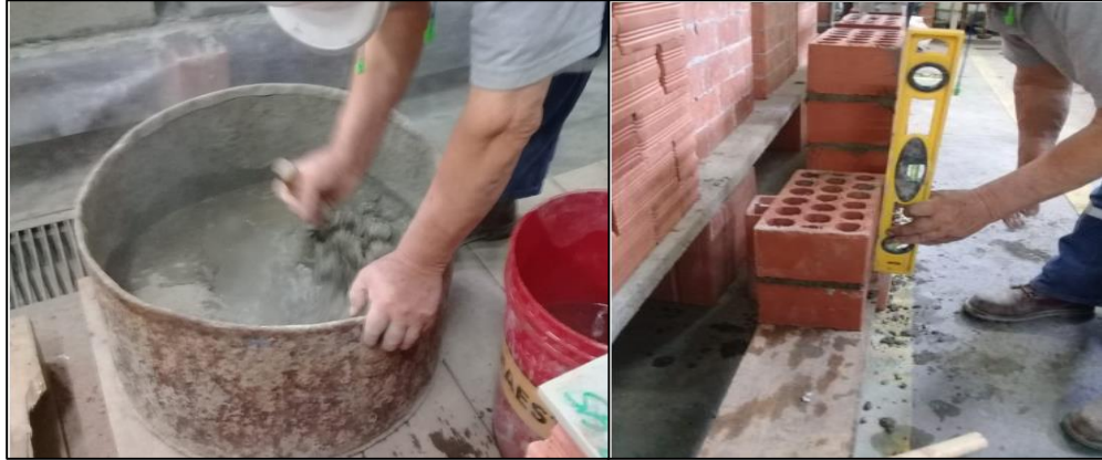
Figura 12: Mezclado del Agregado Grueso con el Cemento (Izquierda); Nivelación de la Pila con Nivel de Mano y plomada (Derecha).
