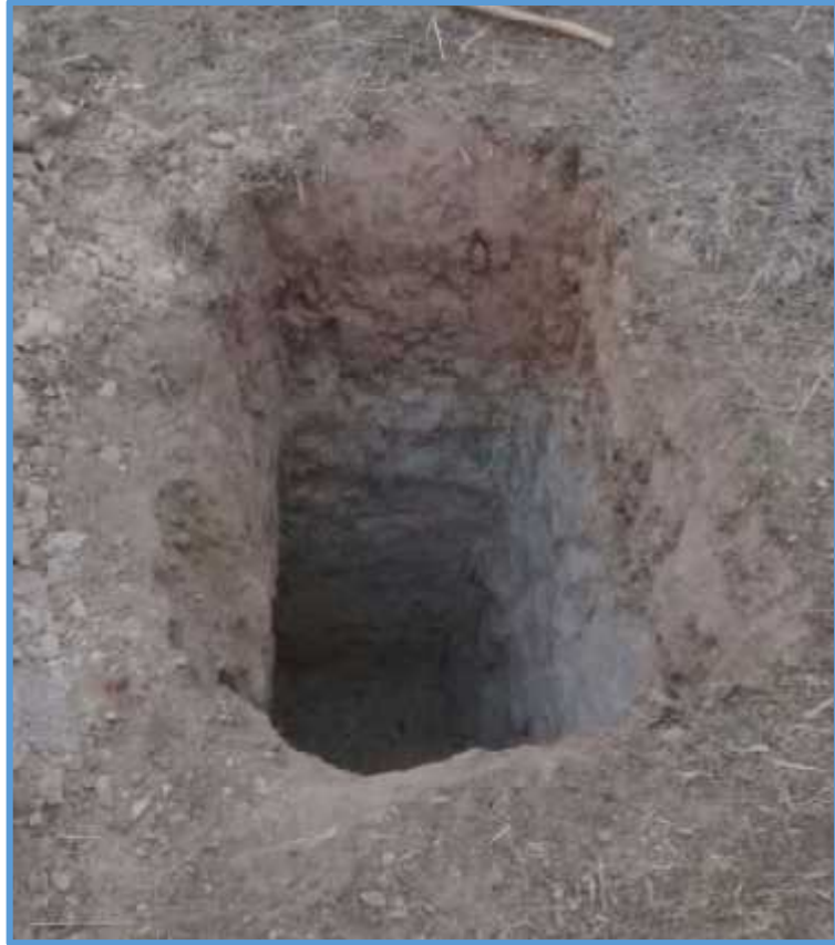
Figura 6.2: Calicata - 2. Reservorio N°1
