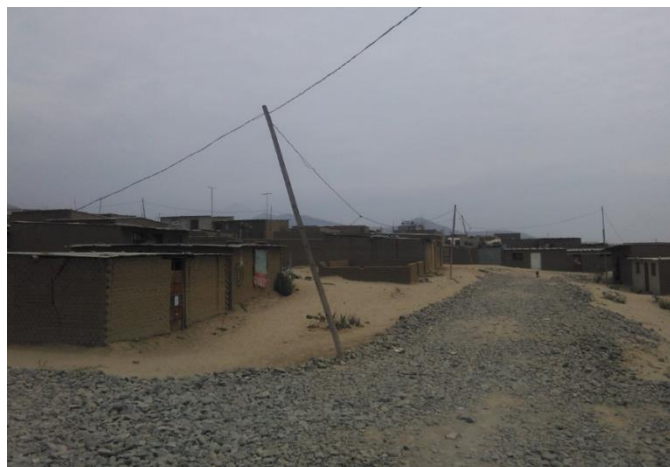
Figura 3 Electrificación colectiva en el centro poblado Alto Trujillo
