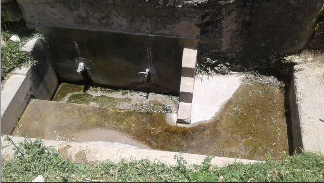
Fotografía 1. Rebose de succión del agua del proyecto que ya cumplió con su periodo de vida útil
