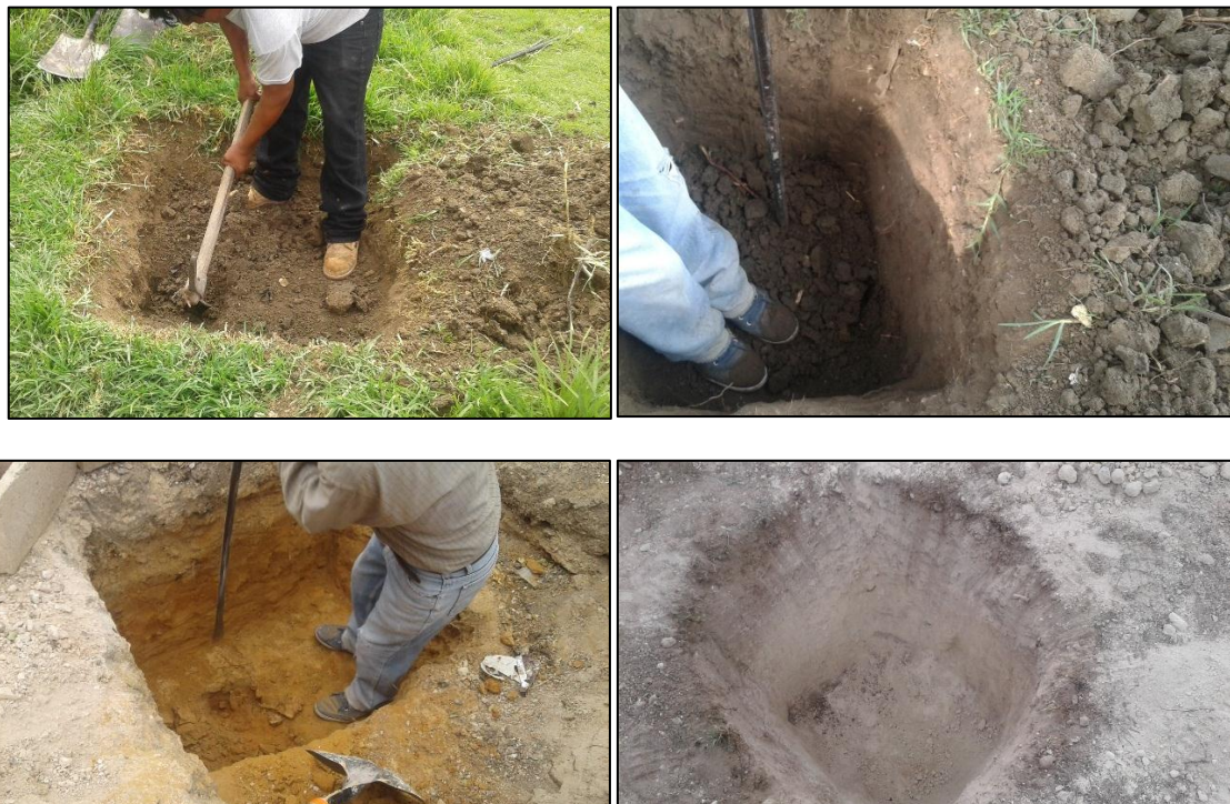
Fotografía 12-15. Calicatas realizadas para la extracción de muestra al cual se le hizo el Estudio de Mecánica de Suelos.
