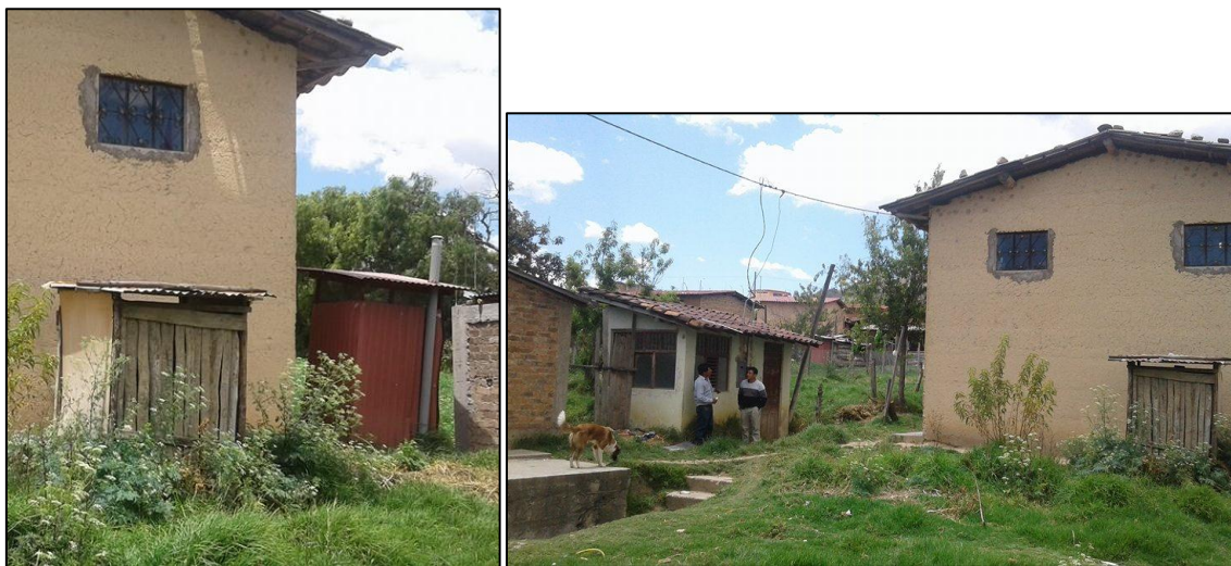
Fotografía 4 y 5. Letrinas ubicadas cerca de la captación, generando contaminación en el agua del subsuelo captada.
