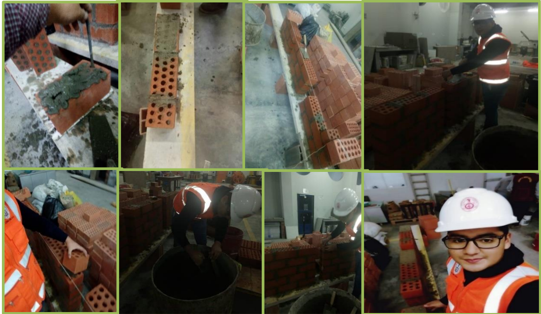
Figura 43. Podemos observar el procedimiento de elaboración de muretes de albañilería con el mortero convencional, con ladrillos Tipo A, Tipo B
