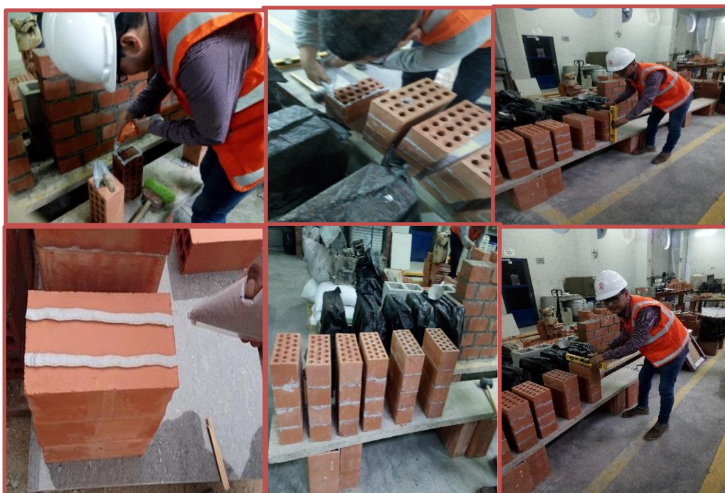
Figura 33. Podemos observar el procedimiento de aplicación del mortero polimérico y la forma de aplicación en la construcción de pilas empleando las unidades de albañilería Tipo A, Tipo B y Tipo C.
