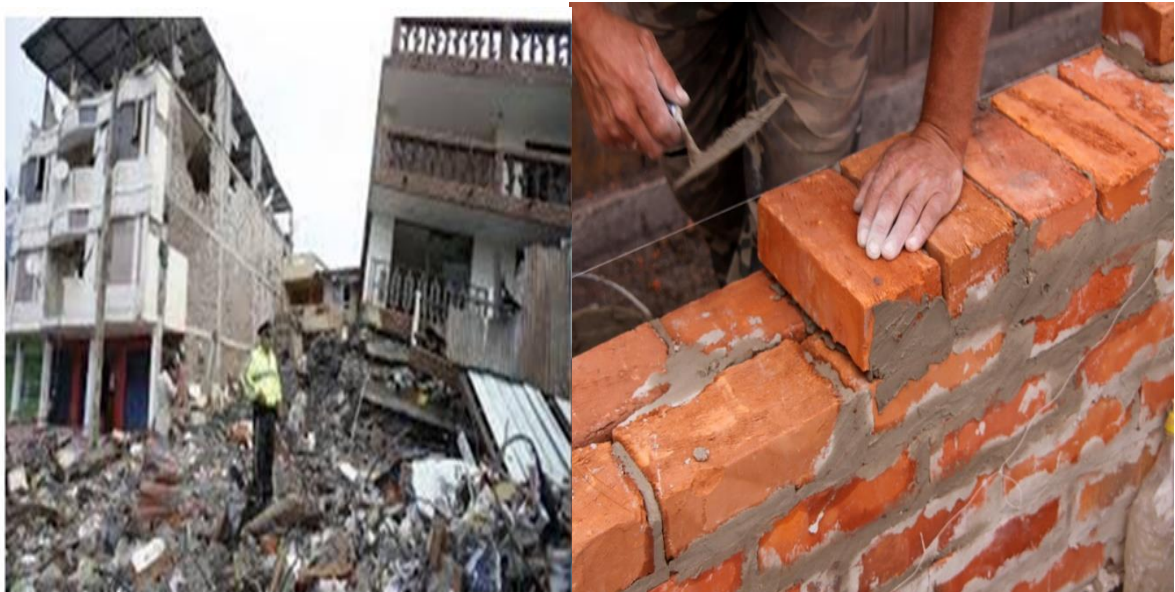
Figura 1. Inadecuada mano de obra y mala calidad de material en muros de albañilería en el Perú Fuente: CENEPRED
