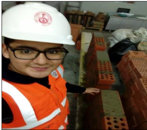
Figura 8. podemos observar el procedimiento de elaboración de muretes de albañilería con el mortero convencional.
