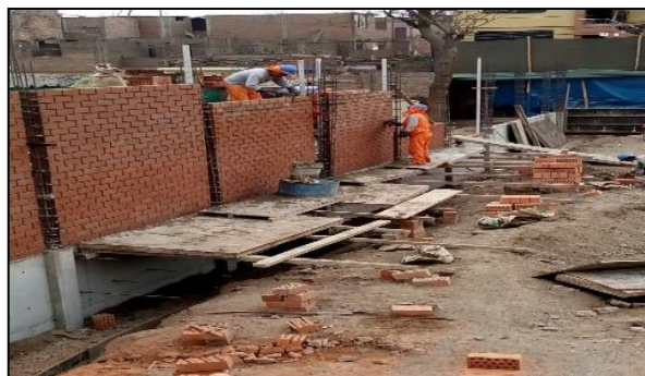
Figura 4. Muros de albañilería con mortero convencional
