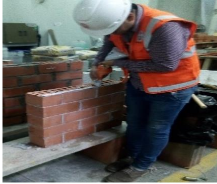
Figura 13. Muretes de albañilería con mortero polimérico
