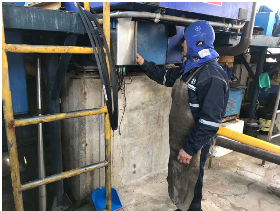
Mantenimiento de pintura, inadecuado EPP – REOPA 2018
