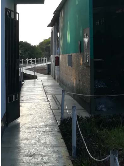
Extintores en inadecuada ubicación REOPA 2018
