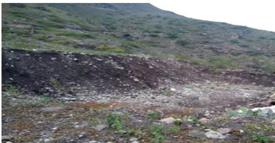
Gráfico 13. Parte Norte de la excavación para relleno sanitario
