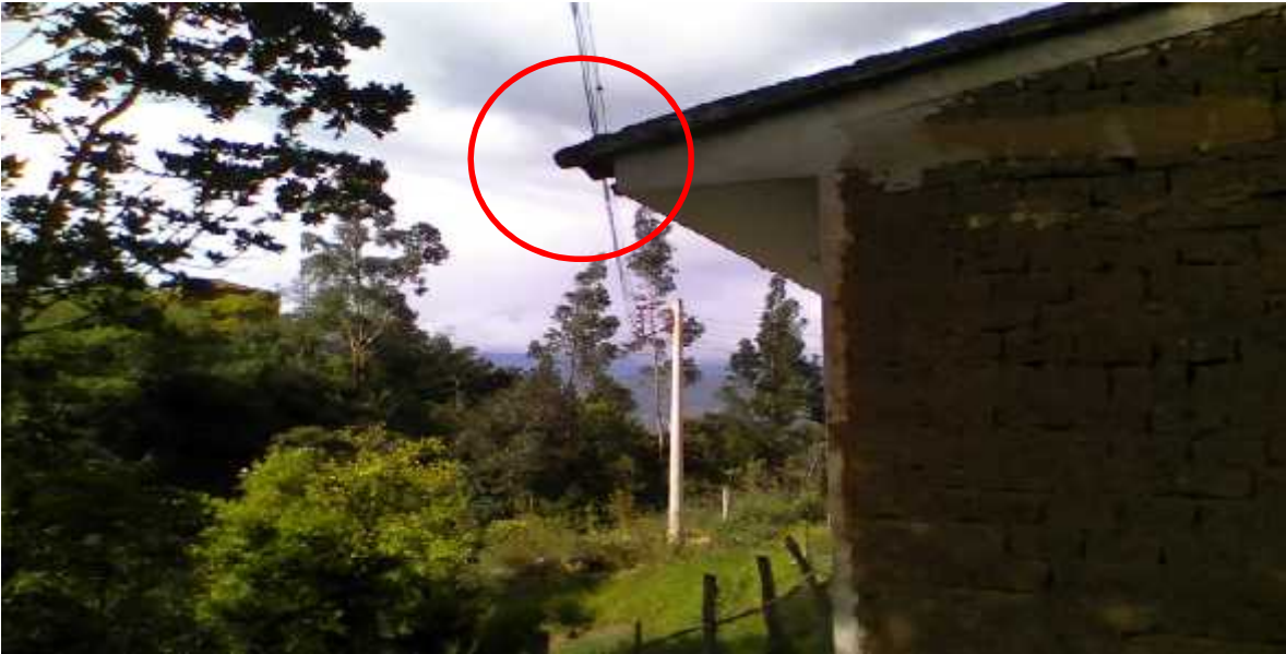
Gráfico (36) Incumplimiento de distancia mínima de seguridad (DMS) en las propiedades del usuario, de la red eléctrica existente
