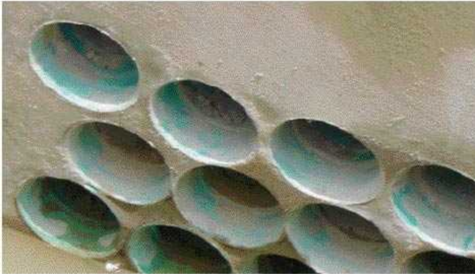
Gráfico (14) Ductos de redes subterráneas
