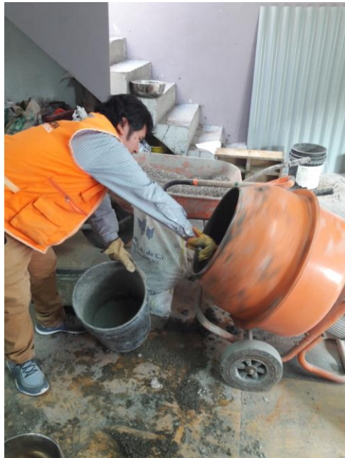
Figura 10. Mezclado de los agregados
