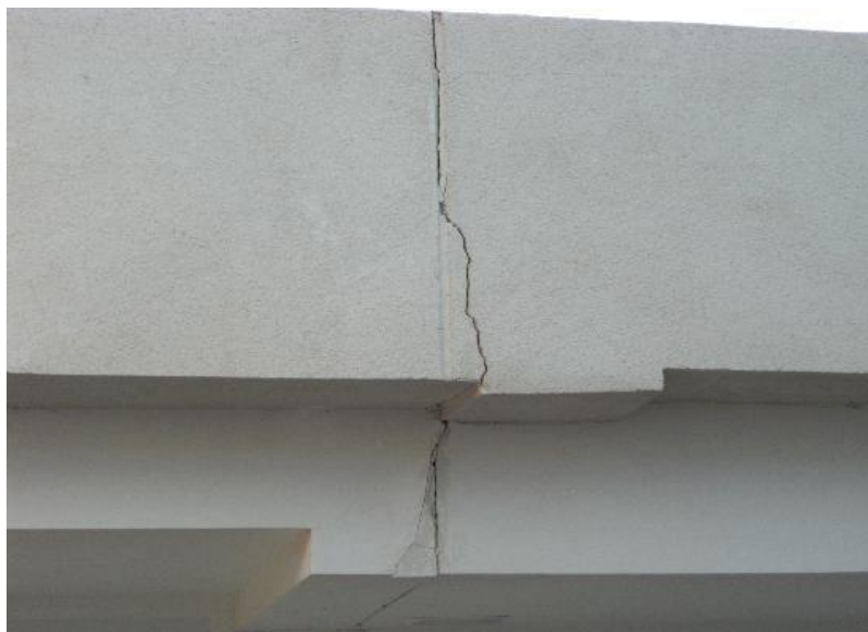
Figura 2. Fisura estructural
