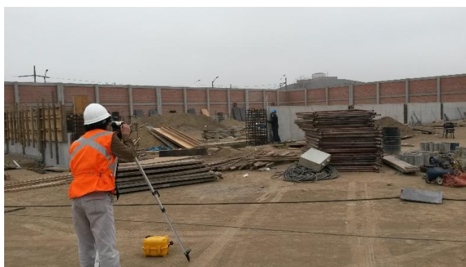
Figura 27. Toma de niveles para fondo de cimentación.
