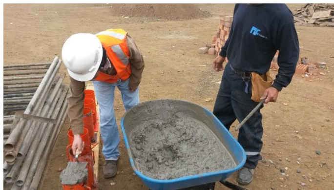
Figura 25. Toma de testigos de la cimentación del proyecto
