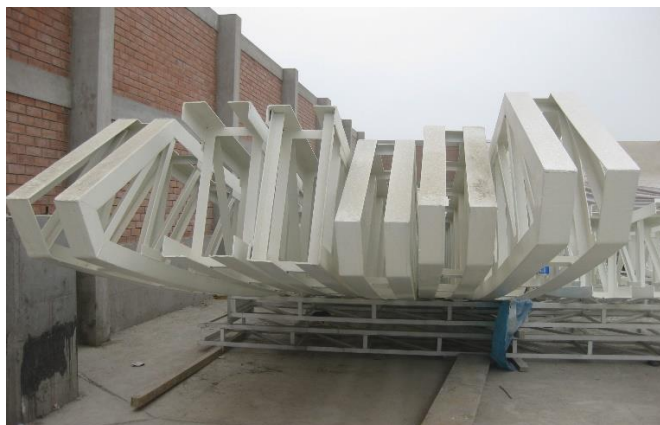
Figura 17. Vigas Tijerales Tipo Arco T-1 vista lateral
