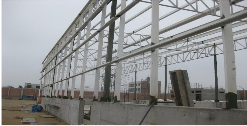
Figura 4. Columnas de cierre de perfiles tipo “C”
