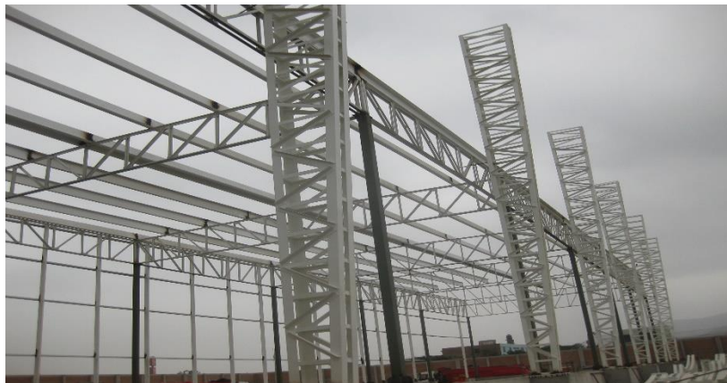
Figura 3. Columnas metálicas reticuladas
