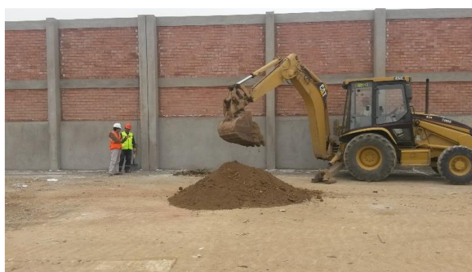
Figura 28. Excavación con maquinaria para cimentación
