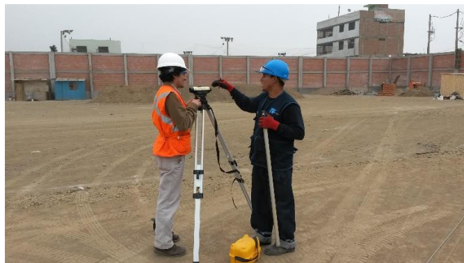
Figura 26. Toma de niveles para fondo de cimentación
