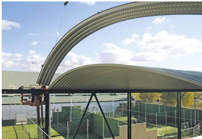
Figura 23. Izaje de los perfiles de cobertura autoportante
