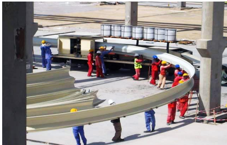
Figura 21. Fabricación del perfil de la cobertura autoportante
