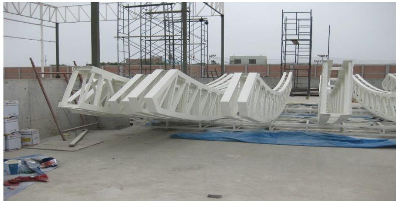
Figura 2. Vigas tijerales principales
