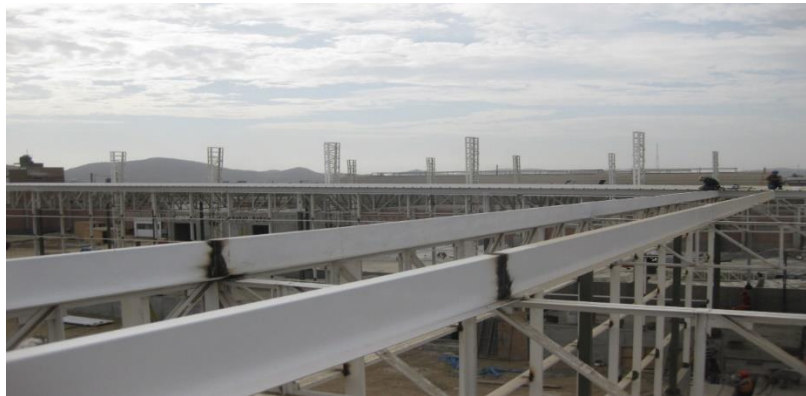
Figura 1. Viguetas con perfil “Z” que conforman el entramado donde se colocará la cobertura
