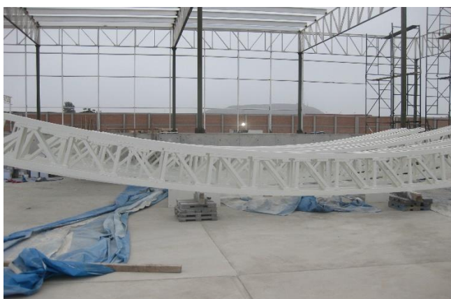
Figura 18. Vigas Tijerales Tipo Arco T-1 vista frontal
