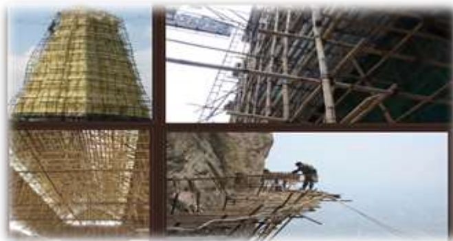
Figura 5. Uso del bambú en andamios.
