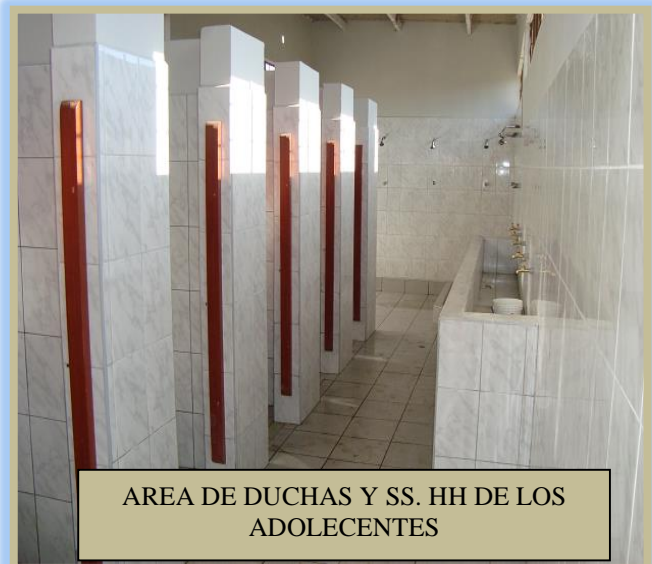
Imagen 26,27: Se observa el área de SS.HH del adolescente infractor
