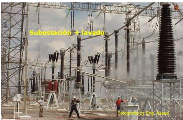
FIGURA 1: Lavado subestación
