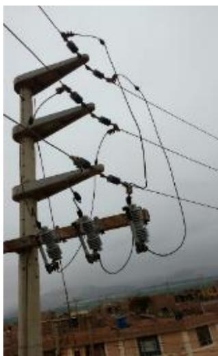
**FIGURA 8: ARMADO MEDIA TENSIÓN CON SECCIONADOR TIPO CUT OUT**
