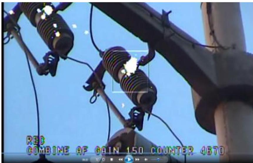
FIGURA 33: EMT N° 00105270-HDS-101. SECCIONADOR TIPO CUT OUT EC BAJO NIVEL DE AISLAMIENTO
