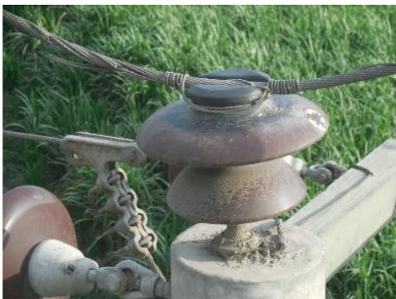
**FIGURA 35: FOTOS. PARTES AISLANTES DE EMT CONTAMINADAS POR POLUCIÓN (ELABORACIÓN PROPIA)**
