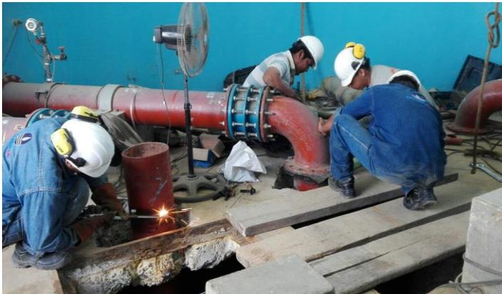
**Imagen 2:** Montaje de línea de impulsión
