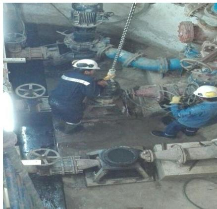
**Imagen 4.** Montaje de electrobomba
