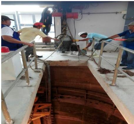
**Imagen 3.** Izado de motor eléctrico
