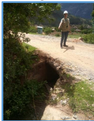
Obra de arte ubicada (Alcantarilla) Fuente: Elaboración propia
