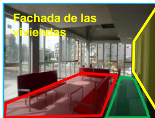
Foto del circulación horizontal paralelo a la fachada de viviendas y zona social.
