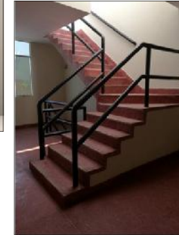
Escalera del 3º nivel ala azotea
