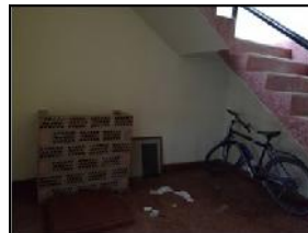
Hall de ingreso y escalera del 1º nivel.
