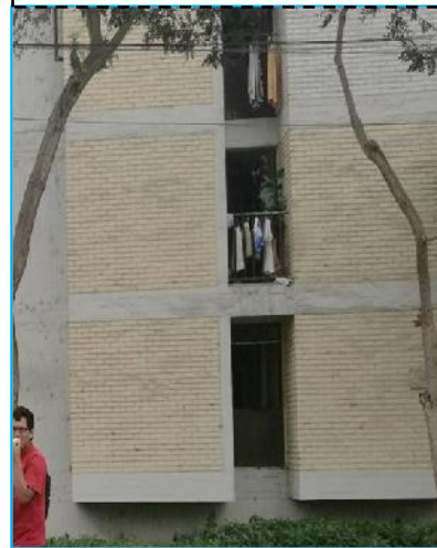
Fotografía de tabiquería dentro del marco de columna y viga peraltada
