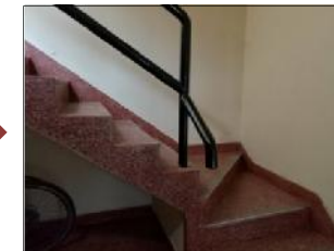
Escalera del 1º nivel al 2º nivel.
