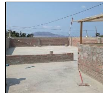
Circulación abierta sin muros que lo limite
