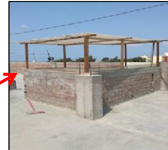
Escalera cubierta en el 4° nivel.
