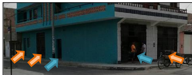
Fachadas lateral y frontal del edificio.
