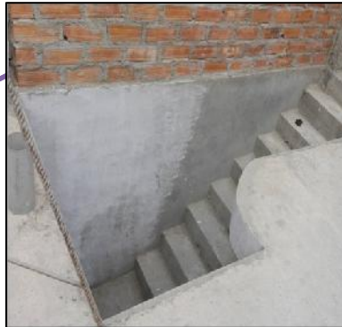
Escalera del 1° al 2° nivel.
