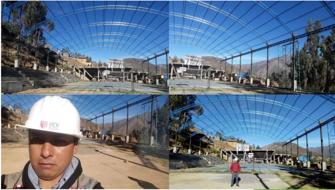
Fotografía 1. Vista panorámica de la visita a la ejecución de la obra del techo metálico de la losa multideportiva de Santa Rosa - Aija
