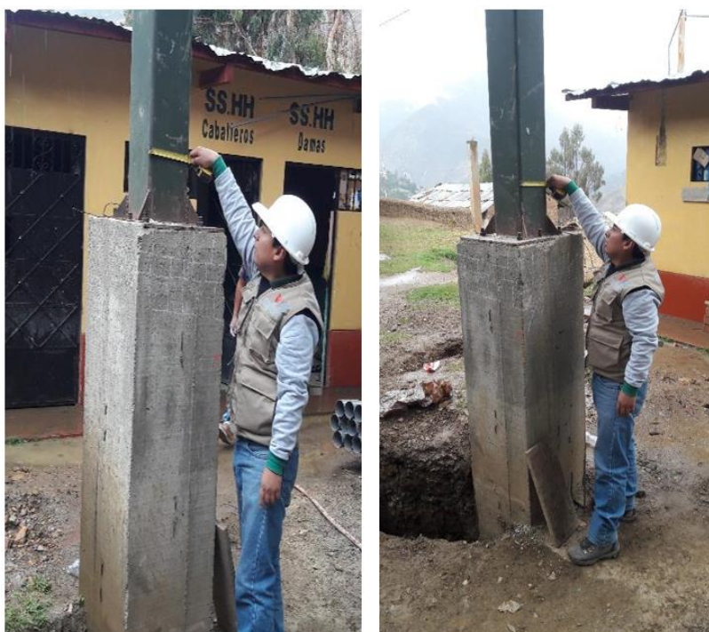
Fotografía 7: Evaluación de los perfiles metálicos.
