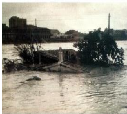
Inundaciones producidas por el Río Turia
