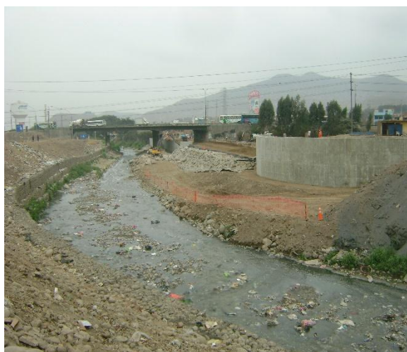
Figura 2: Río Chillón antes de la falla Fuente: Municipalidad de Puente Piedra
