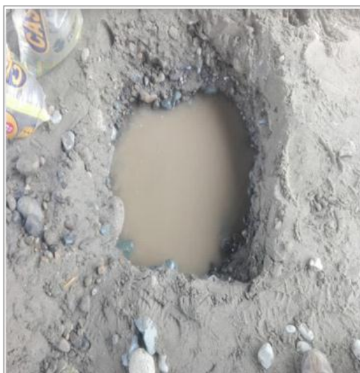
Figura 14: Filtración en el punto de la muestra Fuente: Elaboración propia
