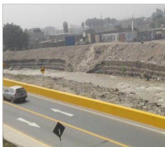
Figura 1: Río Chillón después de la falla Fuente: Elaboración propia
