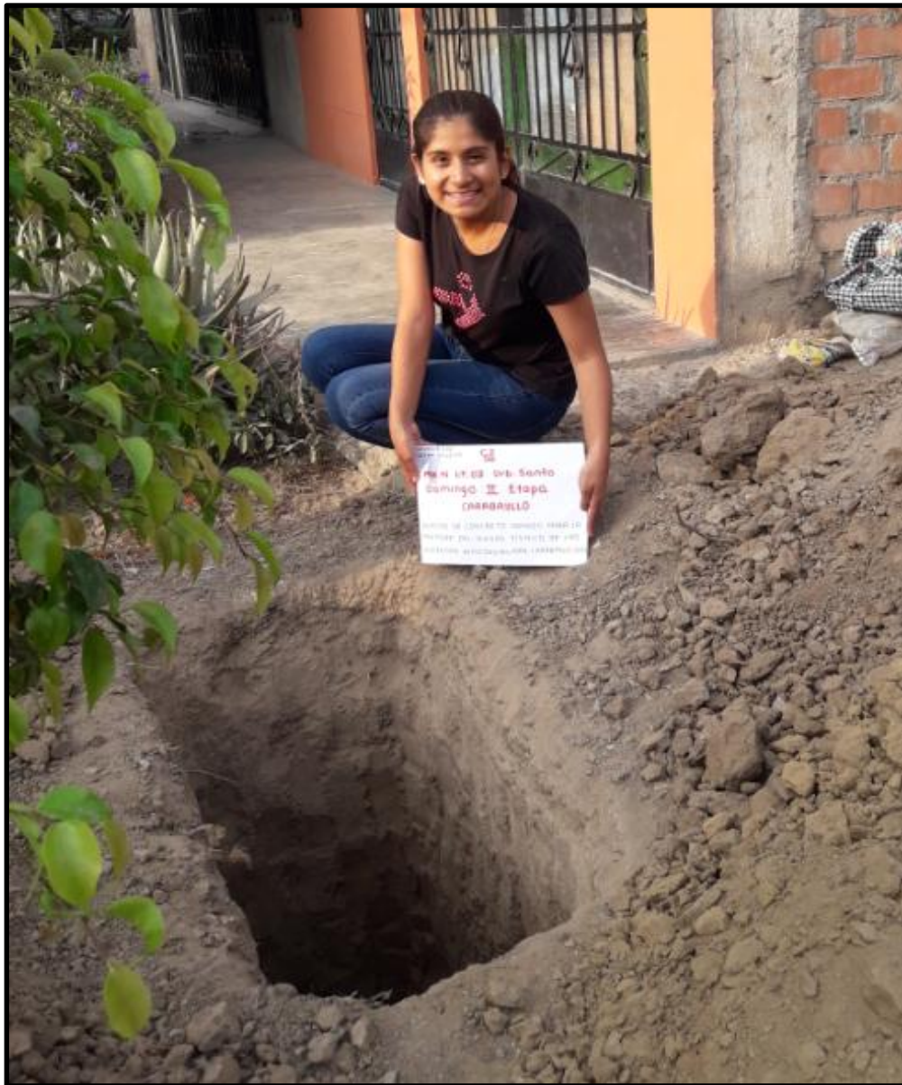
Figura 9: Calicata 02. Fuente propia.
