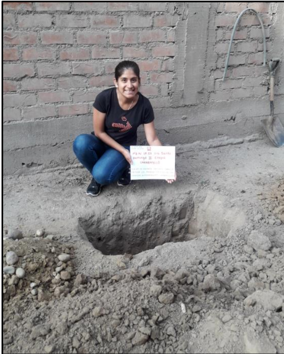
Figura 10: Calicata 03. Fuente propia.
