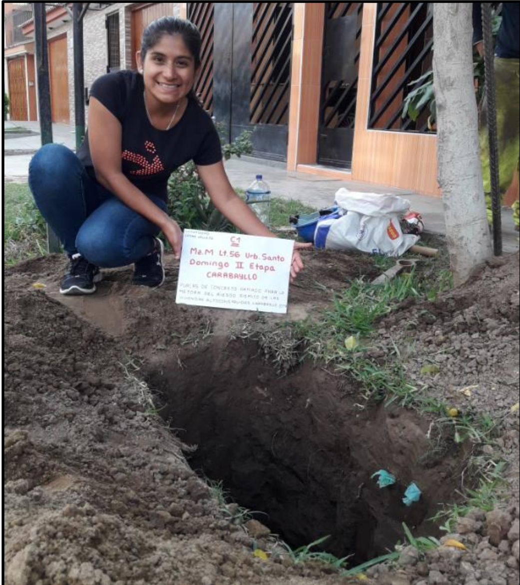
Figura 8: Calicata 01. Fuente propia.
