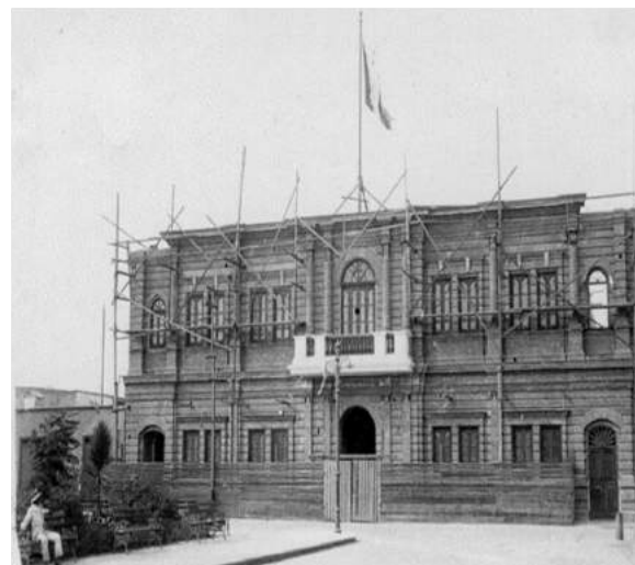
1920. Fachada con el primer y segundo nivel con muros de ladrillo. El tercer nivel de quincha aun no ha sido construido.
