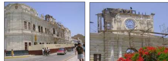
VISTA GENERAL DEL ESTADO ACTUAL DE LA FACHADA
