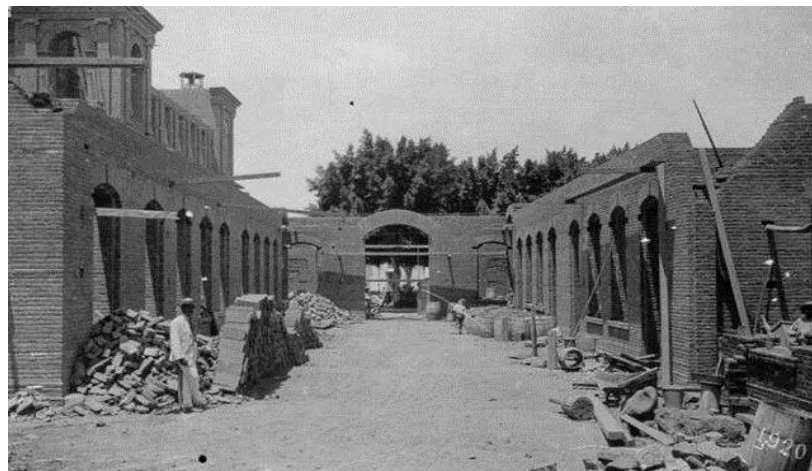
1920. El Palacio Municipal en proceso de construcción. En esta fase aun no figuran las columnas y la galería de la primera planta.
