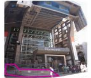
RAMPA DE INGRESO
