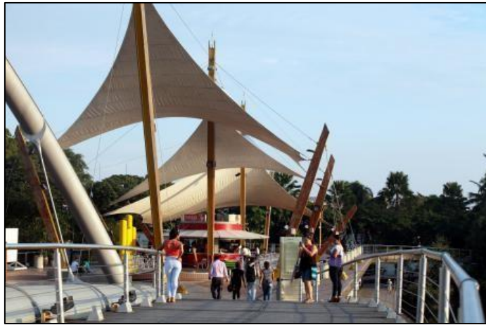
IMAGEN Nº 13: VISTA DE CUBIERTAS
