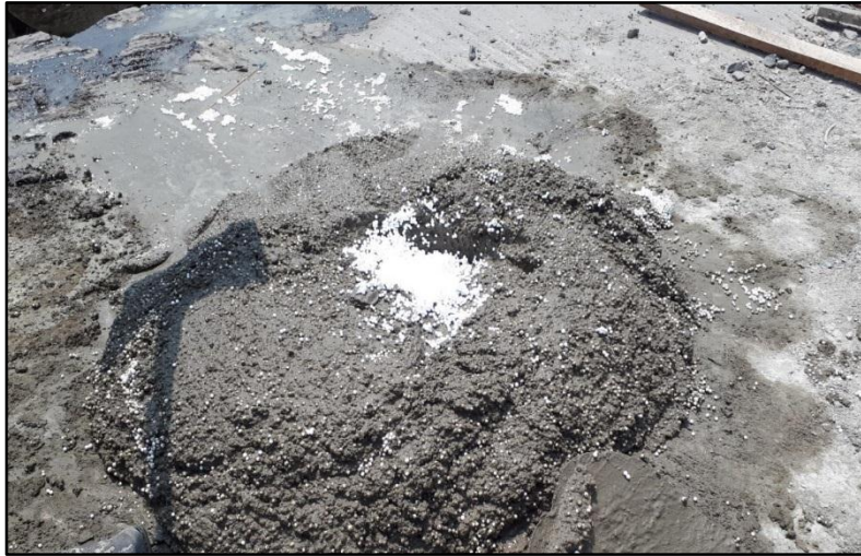
Mescla de concreto Celular
