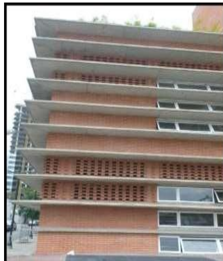
Figura 44: Ladrillos cara vista empleados en la fachada – Fuente google.
