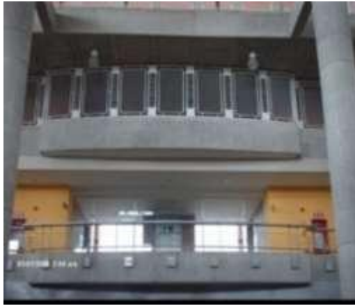
Figura 46: Material predominante concreto expuesto – Fuente google.
