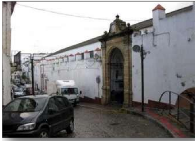
Figura 82: La fachada conserva el estilo del s. XVIII en el que fue construido la edificación – Fuente google.
