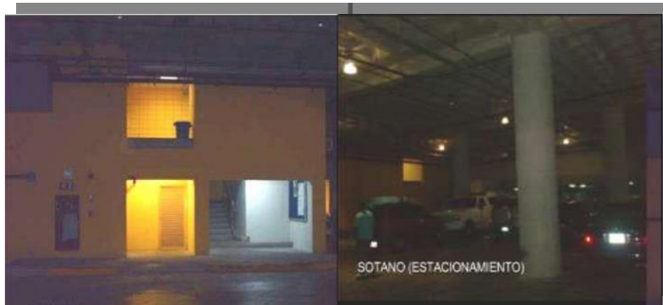
Figura 61: La ubicación de los servicios y abastecimiento en el sótano evita congestión de circulaciones – Fuente google.
