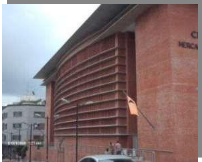
Figura 57: Pared lateral compuesta por ladrillos calados que permite ventilación continua – Fuente google.
