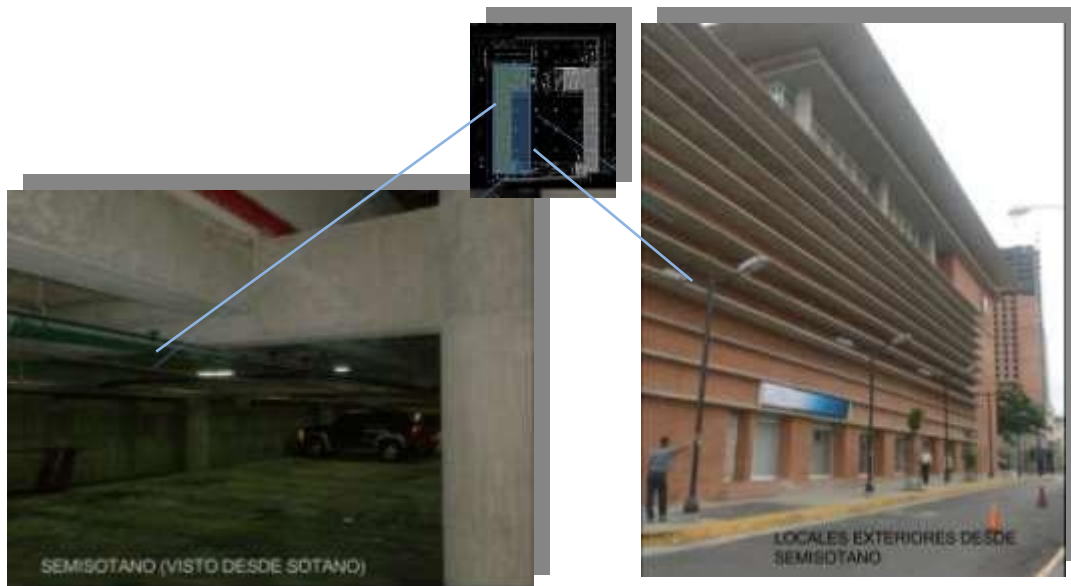
Figura 21: Vista de semi sótano y locales exteriores – Fuente google.
