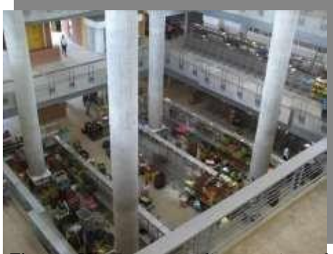
Figura 59: Luces amplias gracias al sistema aporticado empleado – Fuente google.
