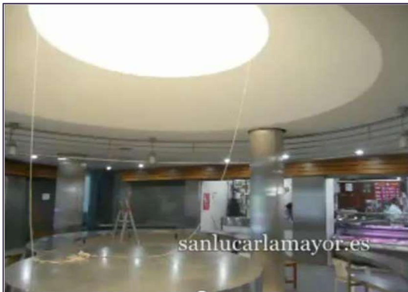
Figura 77: Creación de una lucernario circular para mejorar la iluminación de los espacios – Fuente google.
