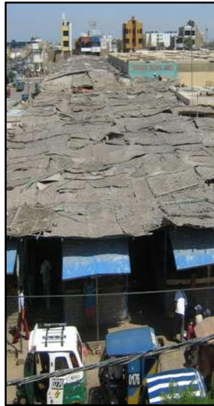
Figura 89: Cubiertas de material perecible en la 1º y 2º ampliación – Fuente propia
