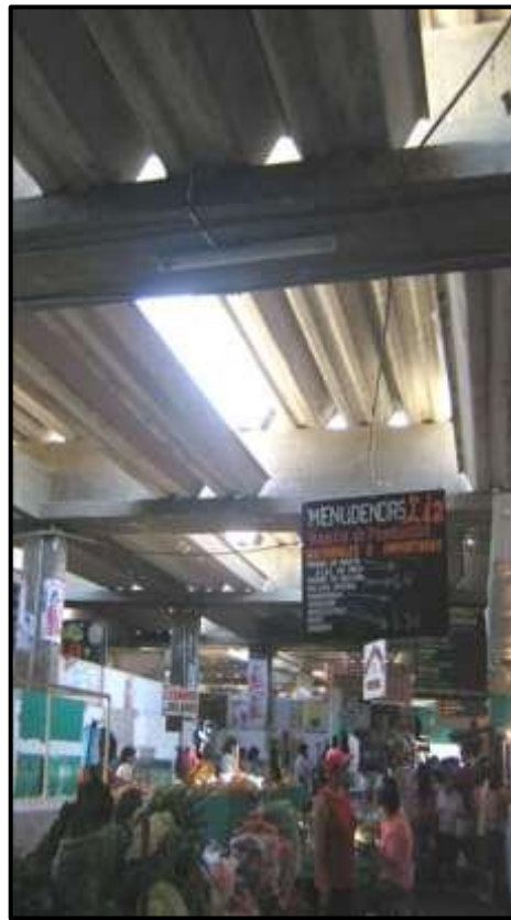
Figura 88: Cubierta de canalones en el Mercado Antigo – Fuente propia
