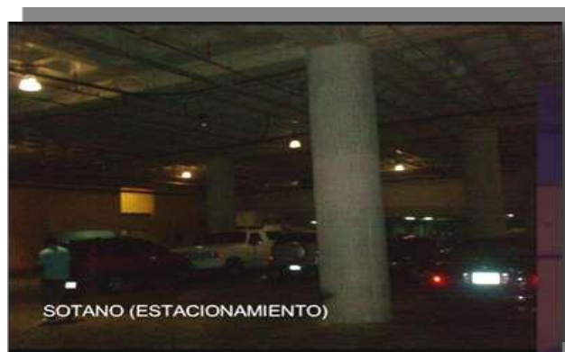
Figura 19: Vista interna del estacionamiento – Fuente google.
