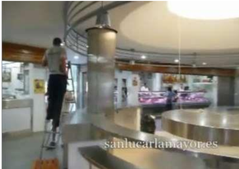
Figura 76: Remodelación de los cielos rasos de todo el proyecto – Fuente google.
