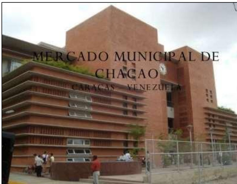
Figura 7: Imagen de la fachada principal del Mercado Municipal de Chacao en Venezuela - JOSE.
