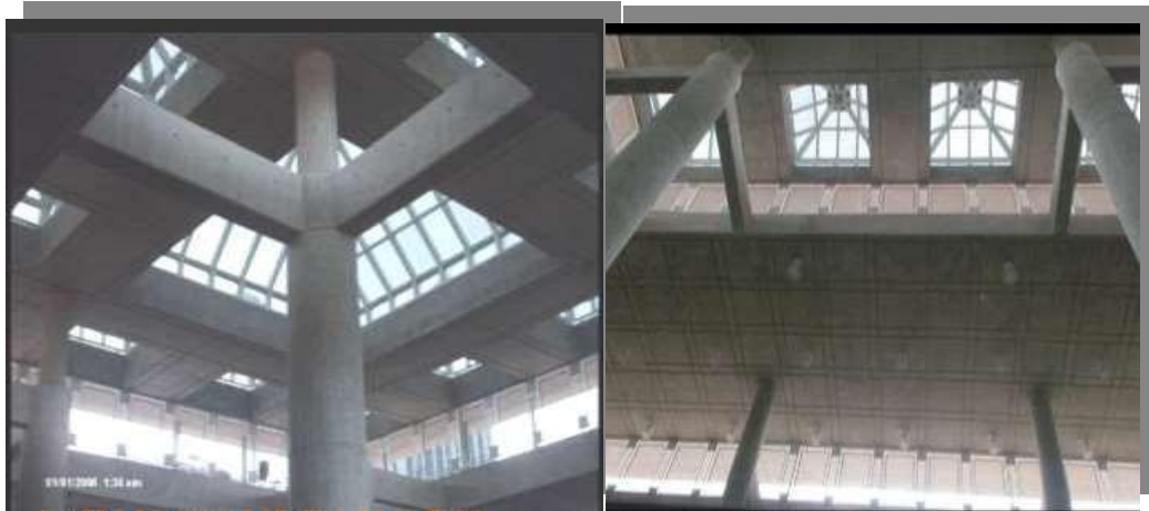
Figura 43: Sistema estructural a porticado con losas nervadas – Fuente google.
