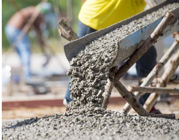
Figura 4. Mezcla de concreto
