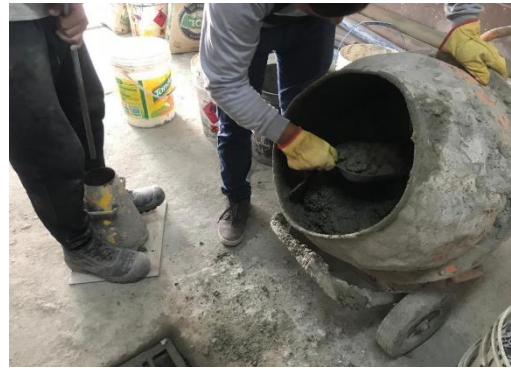
Fotografía 20: Preparación de concreto
