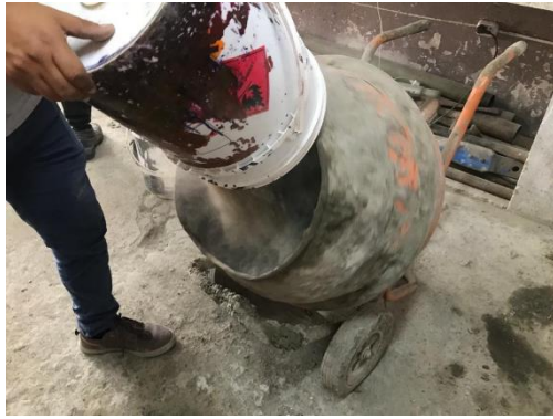
Fotografía 19: Preparación de concreto
