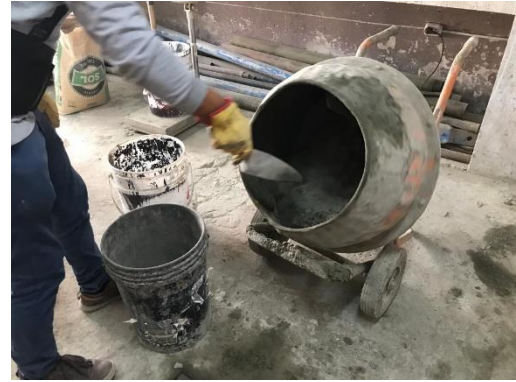
Figura 22. Dosificación del concreto Fuente: Elaboración propia.
