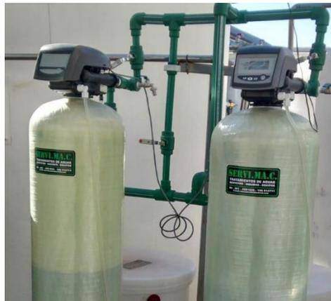
Figura 25: cabezales automáticos para proceso de regeneración (<http://servimacmendoza.com>)
