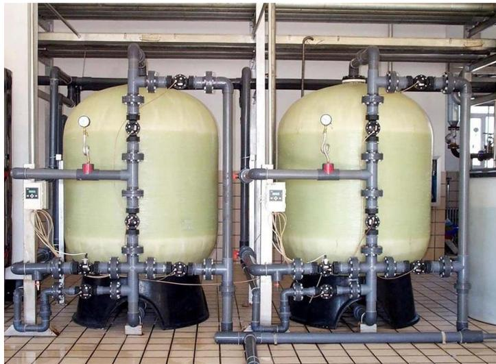
Figura 24: tanques de PRFV para ablandamiento de agua (<http://osmovic.com.ar>)
