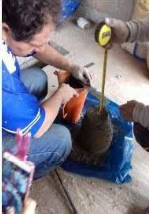
Figura 24: Verificación de la medida del asentamiento.
