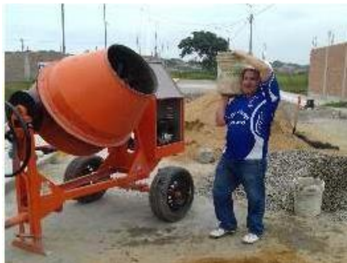
Figura 15: Llenado con agregado grueso en la mezcladora tipo trompo.
