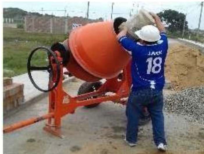
Figura 17: Llenado con agregado fino en la mezcladora tipo trompo.
