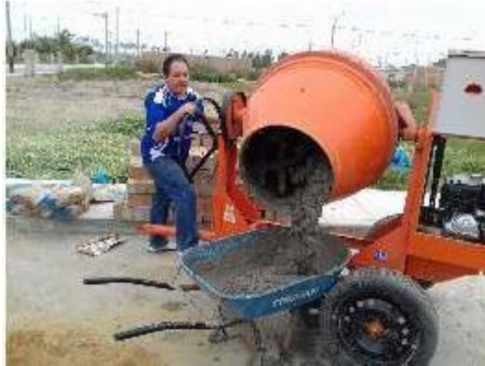
Figura 18: Preparación de mezcla para concreto de f'c = 210 \text{ Kg/cm}^2 .
