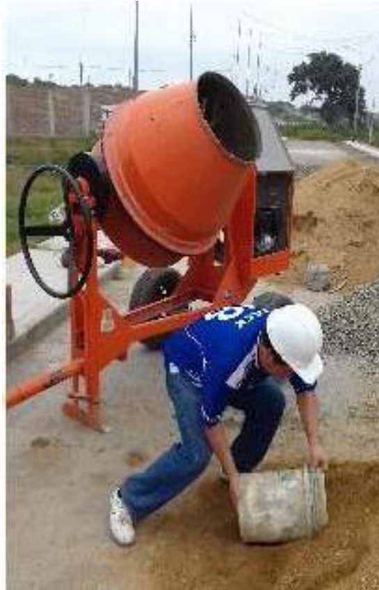
Figura 16: Selección de agregado fino para preparación de mezcla de concreto.
