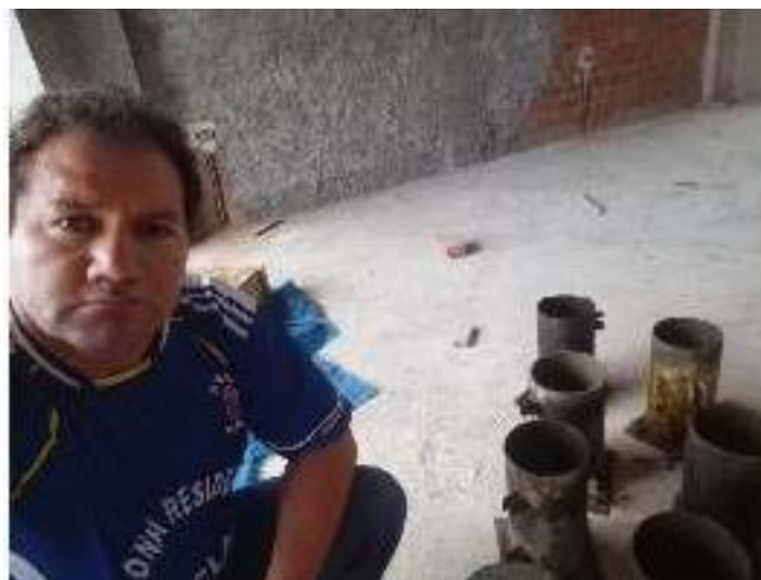
Figura 13: Preparación de moldes para probetas de concreto.
