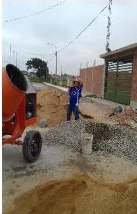
Figura 14: Selección de agregado para preparación de mezcla de concreto.
